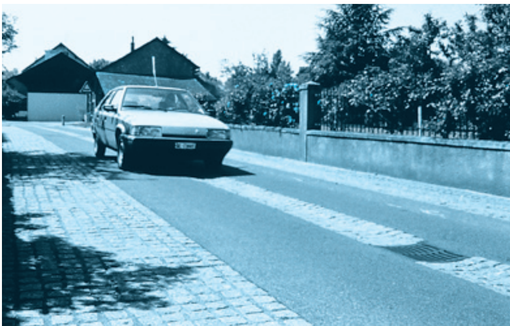
Les caniveaux superficiels découpent la route et modèrent le trafic
