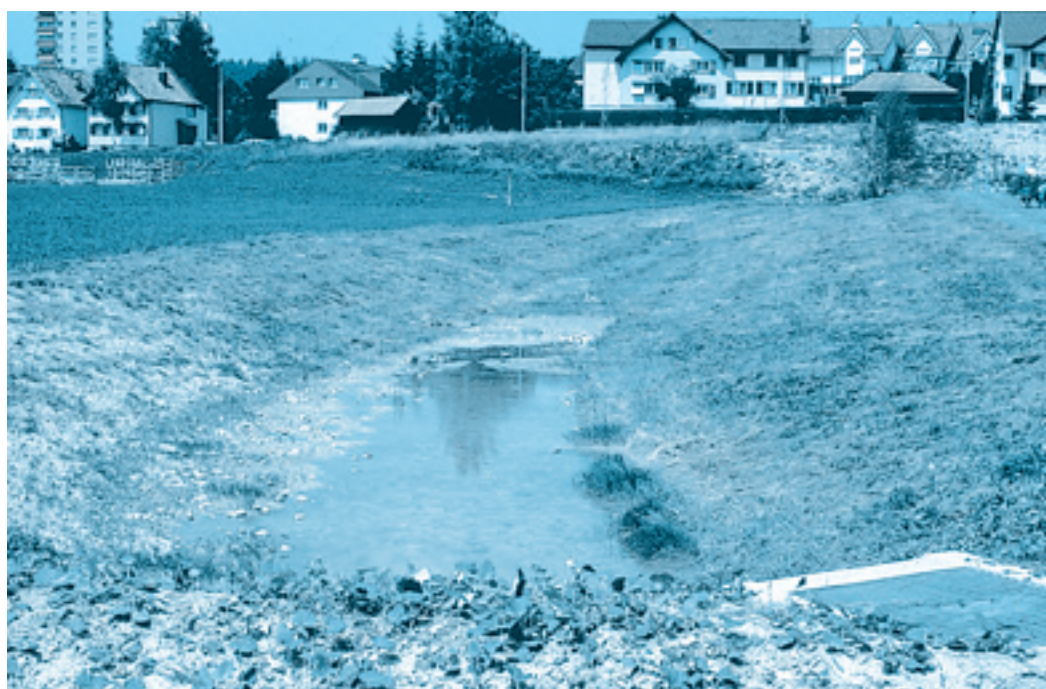
Bassin de rétention et d'infiltration recouvert d'humus
