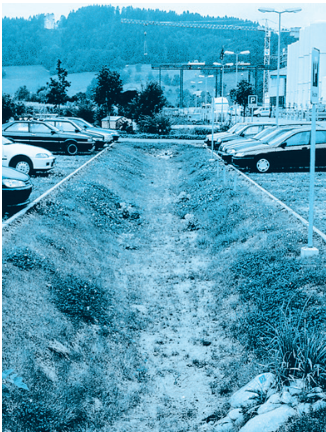
Parking avec une dépression destinée à l'infiltration
