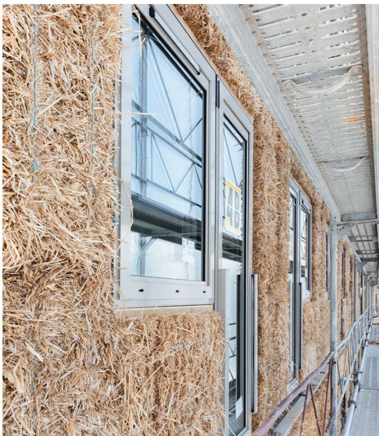
Abbildung 31: Die Nachhaltigkeit steht auch beim Gebäude selbst im Vordergrund: die Fassadenisolation besteht aus Strohballen und Lehm © Julien Gremaud
