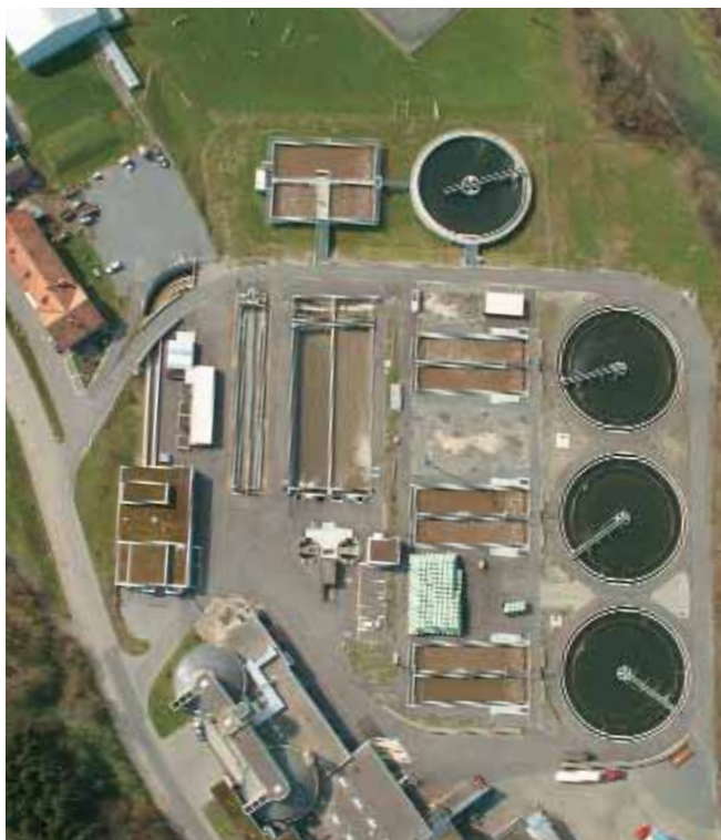
Impianto di depurazione delle acque di scarico, St. Gallen Au. Foto Entsorgungsamt della città di S. Gallo
