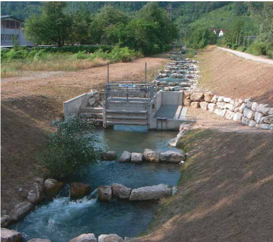
Corso d'acqua d'aggiramento per pesci lungo l'Aare, presso lo sbarramento di Winznau. Foto Armin Peter, Eawag
