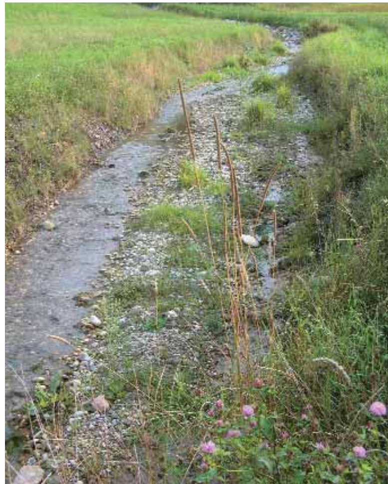
Ripristino dell'alveo del Riedgraben, BE: come ridurre i rischi di piene. Foto RenF / R. Stucki
