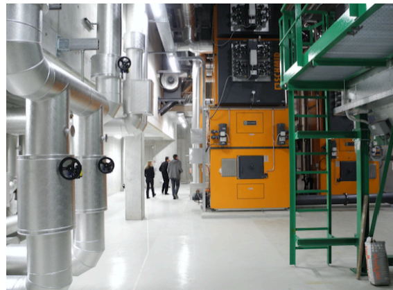
Bild 2: Holzschnitzelkessel im Heizwerk Losone.
