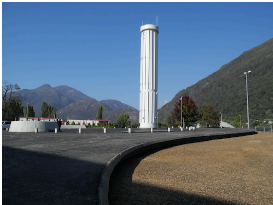
Bild 1: Kamin des unterirdischen Heizwerks in Losone.
