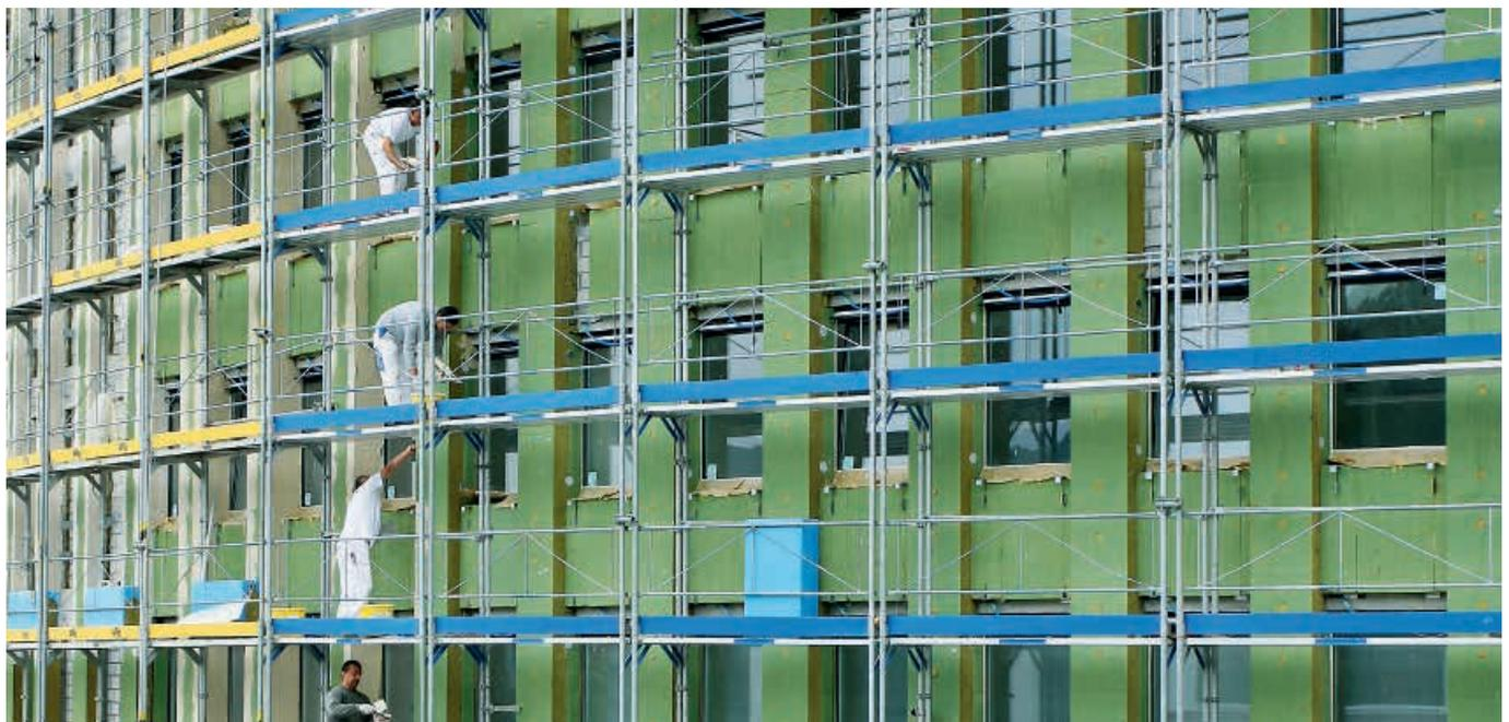
Fig. 3 L'isolamento termico di vecchi edifici consente di ridurre il consumo energetico e le emissioni di CO<sub>2</sub>
