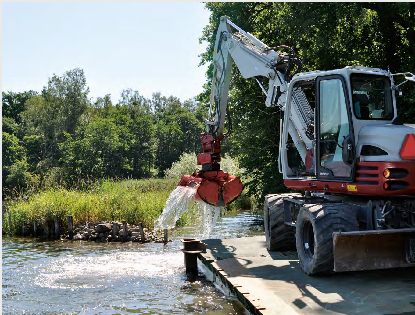
Foce del Petribach , un immissario del Reno presso Schlatt (Canton Turgovia), il 24 giugno 2020. Nella zona della foce si sta scavando una vasca in cui si raccoglie l'acqua un po' più fredda del Petribach . I pesci vi trovano rifugio d'estate quando l'acqua del Reno diventa troppo calda.
