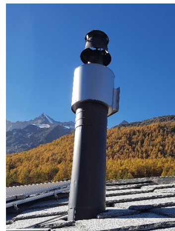
Caminetto con separatore elettrostatico (Nemo Lohberger / FHNW)
