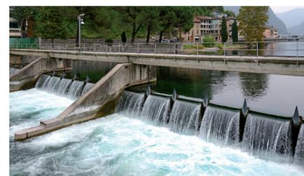
*Lo sbarramento di regolazione di Ponte Tresa è costituito da tre paratie azionate da cilindri larghe 14 metri ciascuna. Il dislivello medio dell'acqua tra monte e valle dello sbarramento è compreso tra 1,5 e 2,0 metri.*
