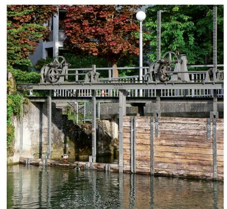
*Dal 1592 il lago di Zugo è dotato di un sistema di sbarramento per regolare il deflusso nella Lorze. Purtroppo non è dato sapere che aspetto avesse l'impianto originario. Il sistema di sbarramento oggi esistente è stato costruito nel 1943 e risanato nel 2002 e consiste in quattro paratoie di legno, ciascuna larga quattro metri (di cui tre ad azionamento elettrico e una azionata manualmente mediante volantino originario).*
