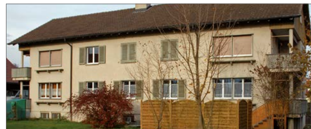
Casa abitativa del 1960 a Kriessern (SG): la sicurezza sismica è stata controllata da un ingegnere sismico nell'ambito della pianificazione delle misure di conservazione ed è stata valutata sufficiente.
