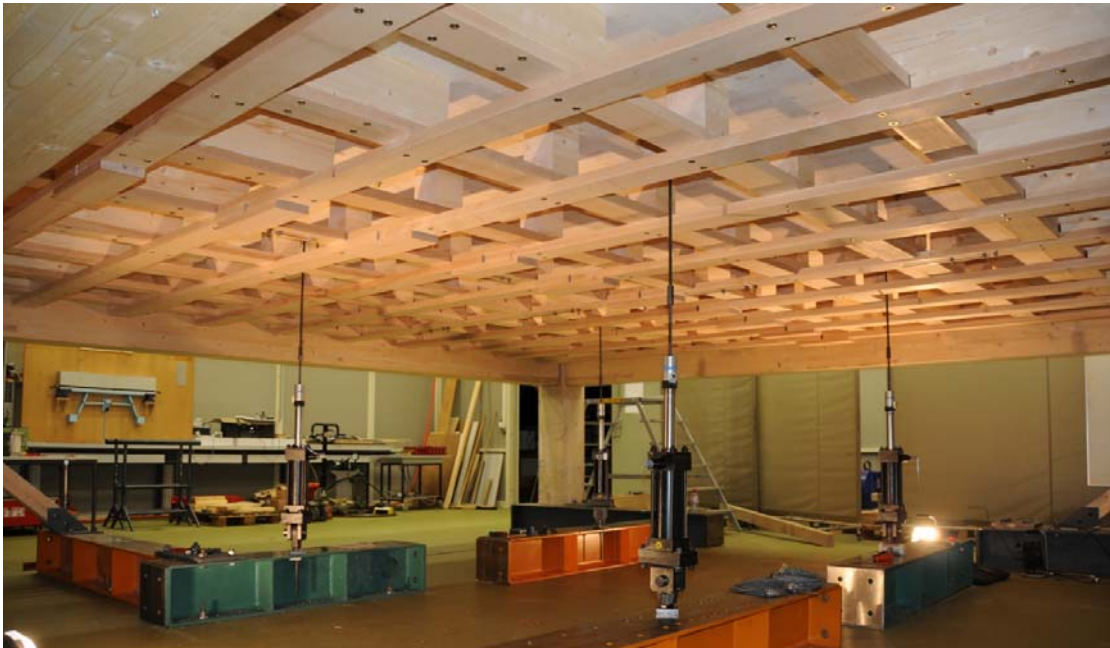
Abbildung 4: Ansicht auf die Buchenholzlamellen der Holzdecke
