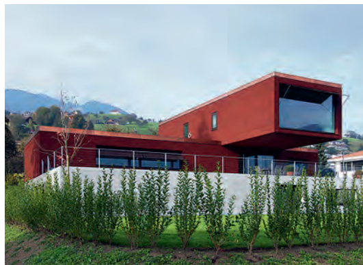
Figur 1: Grosse Auskragungen sind je nach Erdbebenzone auch bei Einfamilienhäusern speziell zu untersuchen.
