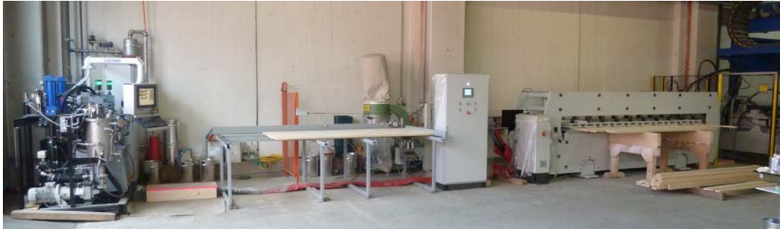
Abbildung 1 Pilot-Versuchsanlage bei der Fa. Schilliger
