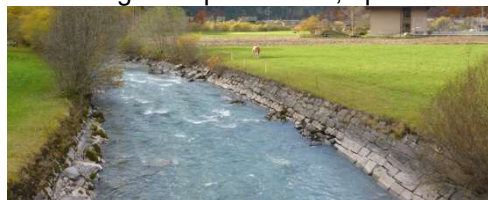
Argine impermeabile, ripido, lineare
