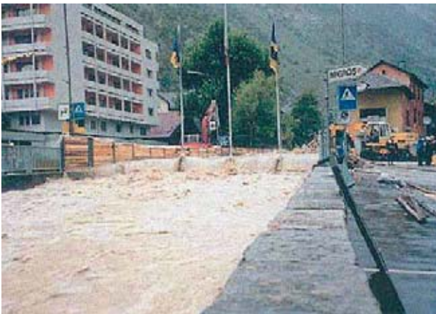
Fotos 3: Lonza im Bereich des Gefällsknickes mit der Dorfbrücke (oben links). Hochwasser vom 15. Oktober 2000: Brücke Kraftwerk Löttschen flussabwärts bis Dorfbrücke mit erhöhten Ufermauern und den Sofortmassnahmen (oben rechts), überflutete Dorfbrücke mit Dammbalken (unten links), und bordvoller Abfluss unterhalb der Dorfbrücke (unten rechts).
