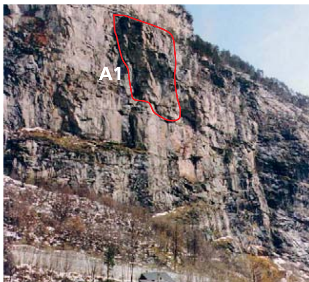
Photo 1: Falaise dominant le village de Gondo (www.crealp.ch). On remarque le piège à blocs à l'amont de maisons.
