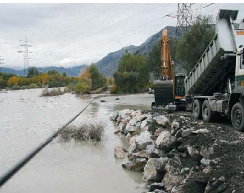
Photo 7: Colmatage de la brèche du Rhône
