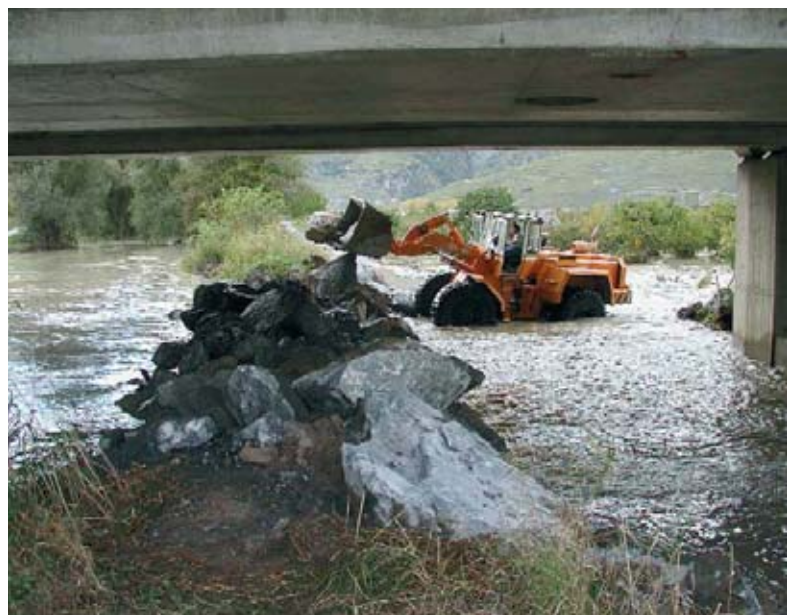
Photo 9: Colmatage de la brèche du canal Sion-Riddes
