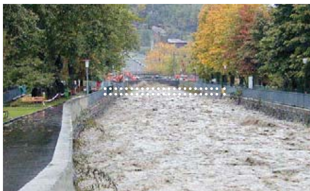
Foto 6: Blick in Fliessrichtung auf den Unterlauf des Saltinakanals auf der Höhe des Spitals. Die Stelle, wo der Fussgängersteg abgebrochen wurde, ist mit einer punktierten weissen Linie markiert. Der Abfluss staute sich zweitweise und leicht an der verschalteten Festungswachtbrücke (Foto: André Burkard).
