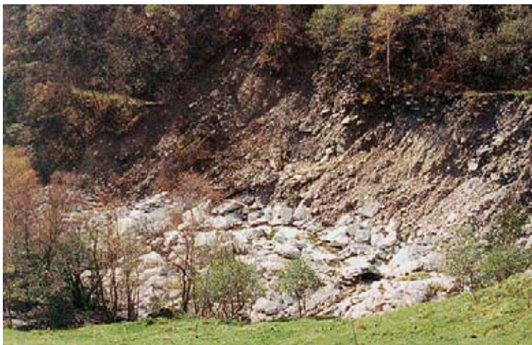
Foto 1: Ausgeprägte Verbreiterung der Sohle und Böschungserosion bei Tutschetta.
