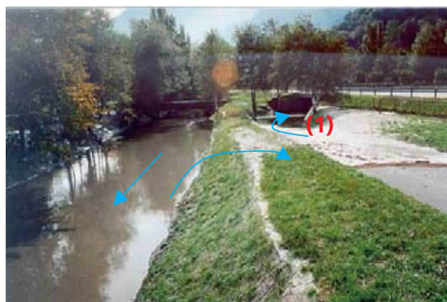
Photo 1: Canal de la Salanfe – Passage sous la A9
