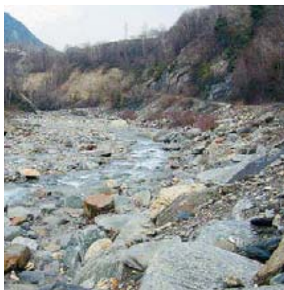
Foto 2: Leere obere Geschiebekammer im Grindji. Foto in Fliessrichtung, Aufnahme vom 10. Februar 2000 (André Burkard).
