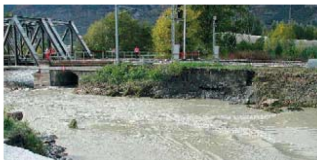
Photo 5: Retour au Rhône à l'amont du pont CFF
