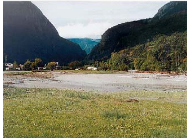
Photo 4: Inondation à l'amont du camping
