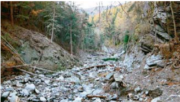
Foto 1: Gerinnequerschnitt auf Kote ~1160. Beträchtliche Seiten- und Tiefenerosion ist sichtbar. Die Gerinnebreite beträgt in diesem Abschnitt etwa 10 m.
