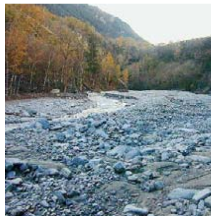
Foto 4: Gefüllte obere Geschiebekammer im Grindji. Foto in Fliessrichtung, Aufnahme vom 4. November 2000 (André Burkard).
