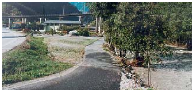
Photo 1: Débordement à l'amont du pont MO
