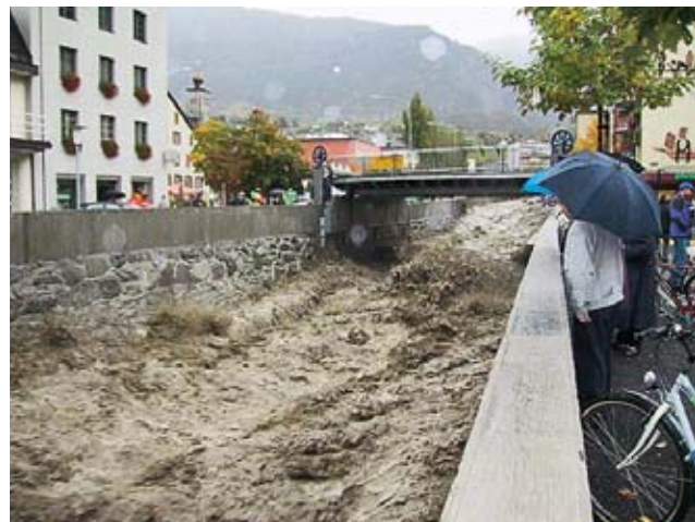
Foto 5: Angehobene Hubbrücke über die Saltina. Sonntagvormittag, 15. Oktober 2000 (St. Walther, Brig-Glis).
