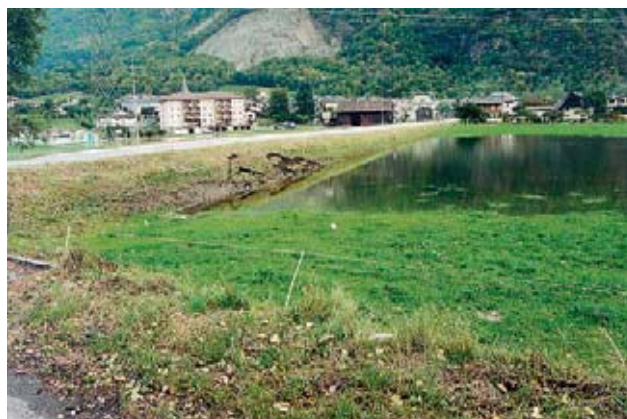
Photo 11: Débordement à l'amont du pont de Collonges
