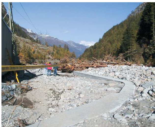
Photo 5: Ouvrage d'entrée du Grosses Wasser dans le barrage de Sera après les intempéries.
