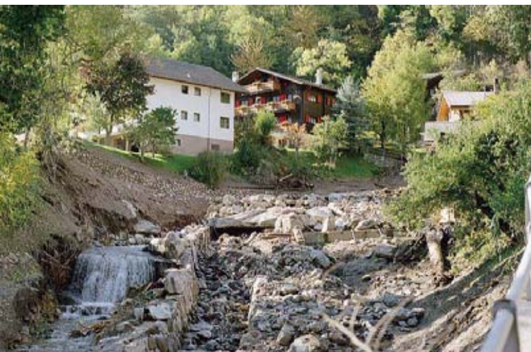
Foto 3: Das Foto zeigt den Gerinneabschnitt im Dorfkern nach dem Murgangereignis. Der Dorfbach fliesst neben der zerstörten Schale. Auf der rechten Seite des Fotos standen kleinere Landwirtschaftsgebäude, welche durch den Murgang zerstört wurden.
