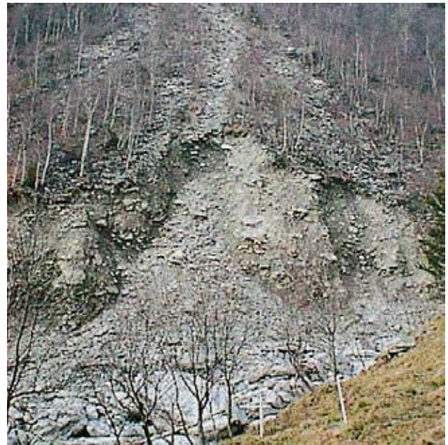
Foto 3: Anbruch des Schuttkegels der Runse bei Tutschetta, punktueller Beitrag von rund 8000 m 3 Feststoffen.
