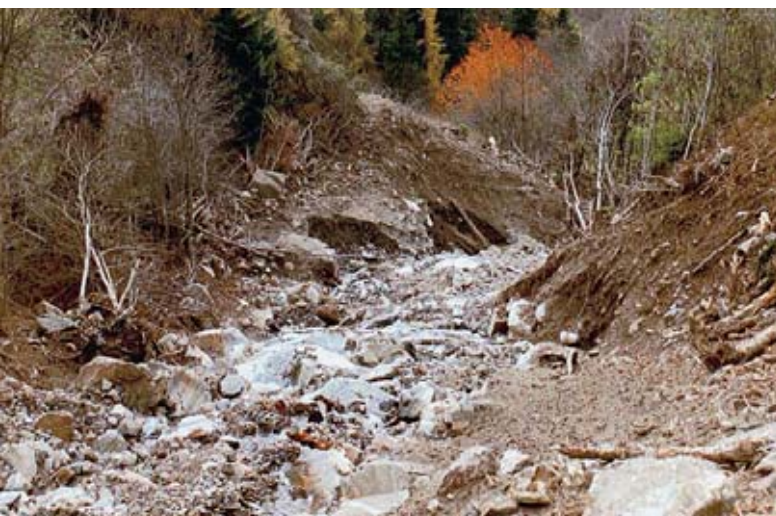
Foto 2: Erosionsspuren und seitliche Ablagerungen zwischen Kote 1350 und 1340.
