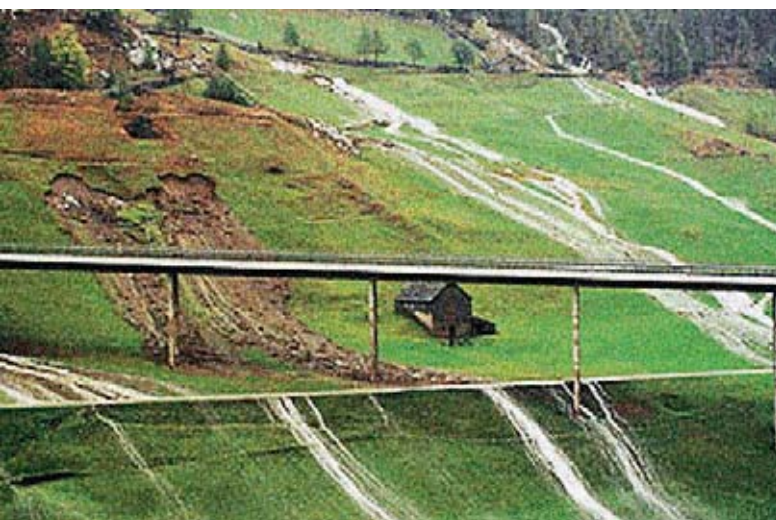
Fig. 5-14: Cette photo du viaduc de la route du Simplon prise depuis Simplon-Dorf montre l'écoulement de l'eau en surface et, à gauche du chalet, deux oavilles tout à fait représentatives des centaines qui se sont déclenchées pendant les intempéries de la mi-octobre 2000.
