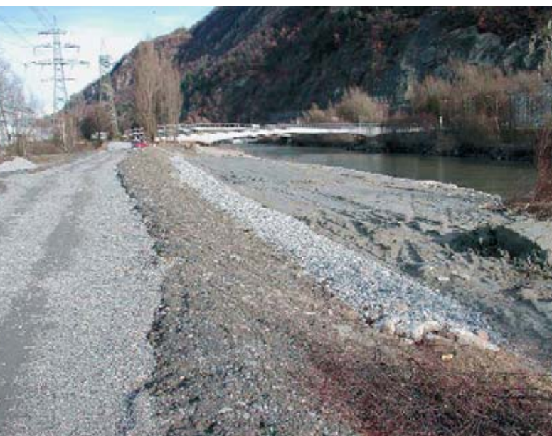
Photo 8: Digue du Rhône reconstruite
