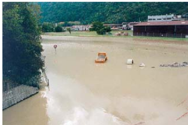
Photo 7: Passage sous l'autoroute (Ouest A9)
