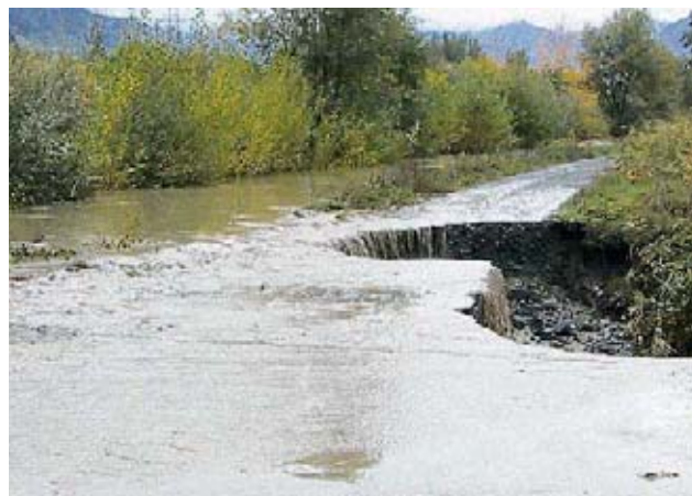
13h30: Ouverture de la brèche
