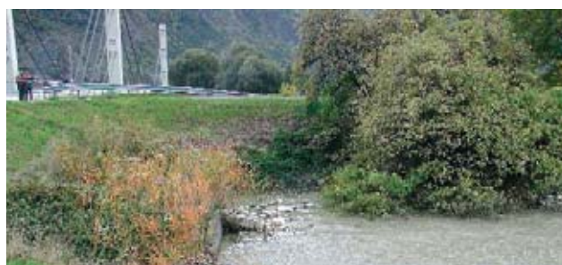
Photo 6: Exutoire de la partie souterraine du canal Sion-Riddes à l'aval du pont Leytron-Riddes
