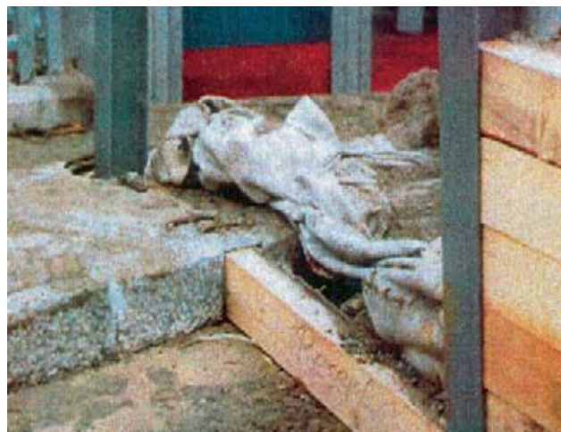
Fotos 2: Mobile Elemente aus Stahlträgern und Dammbalken.
