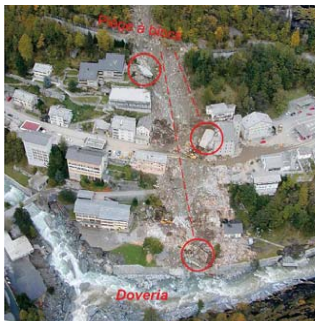
Photo 2: Tranchée créée dans le village de Gondo. On distingue le piège à bloc, les trois éléments de mur (cerclés), la Doveria et la route internationale du Simplon qui traverse le village d'ouest en est (www.crealp.ch).
