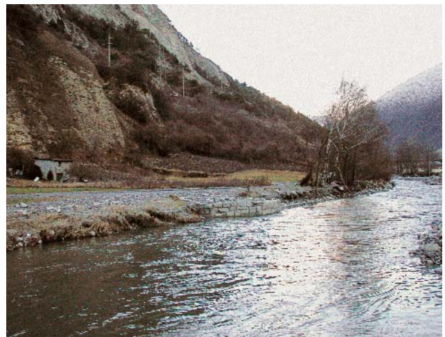
Photo 10: Culée du pont des Parties
