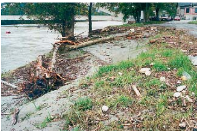
Photo 10: Amont du pont de Collonges (rive droite)
