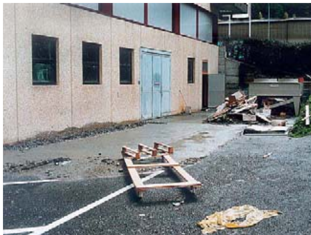
Photo 6: Aval de la halle commerciale
