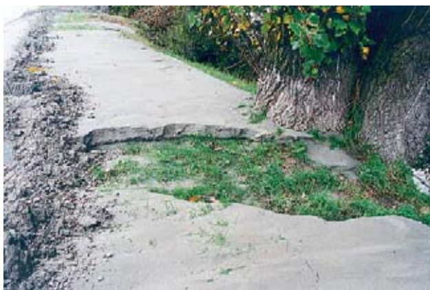
Photo 4: Sommet de digue en rive gauche
