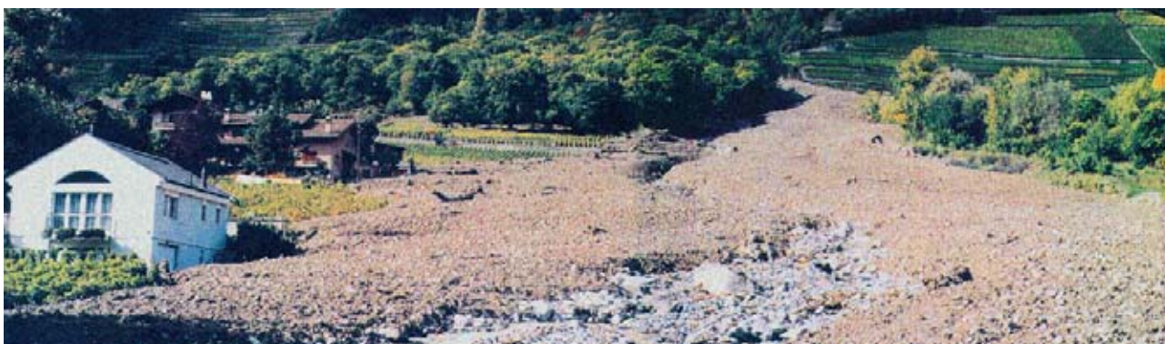
Photo 2: Vue de la zone de dépôt de la lave torrentielle. Les particules fines ont été délavées dans le chenal central par les écoulements d'eau claire qui ont succédé aux laves torrentielles (photo du 16 octobre 2000).
