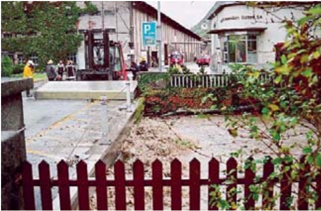
Photo 3: Photo du pont reliant le parking à l'usine Alcan durant la crue (source: Alcan).
