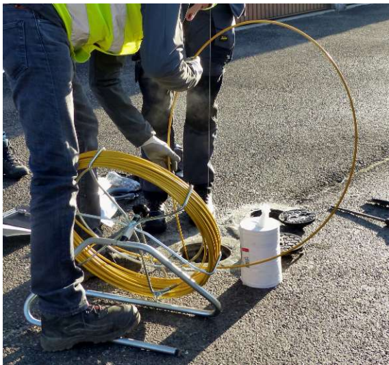
Tige rigide permettant de "pousser" les modules PFM si le piézomètre est déformé
