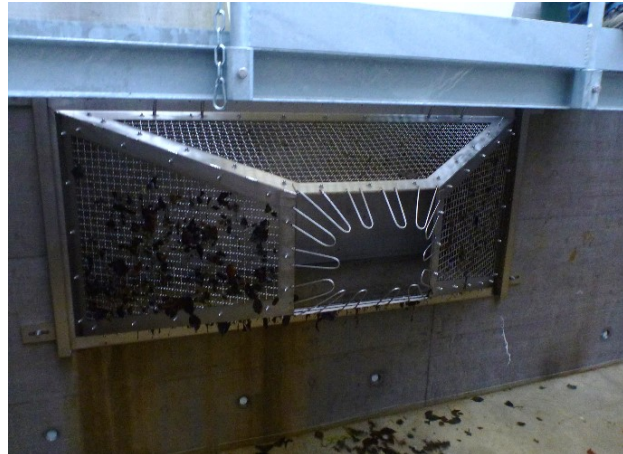
Zählbecken mit Reusenkehle aus Gitterdraht, die ein Zurückschwimmen der Fische in den Schlitzpass erschwert. Verlegung bei hohem Gschwemmselanfall möglich (AquaPlus)
