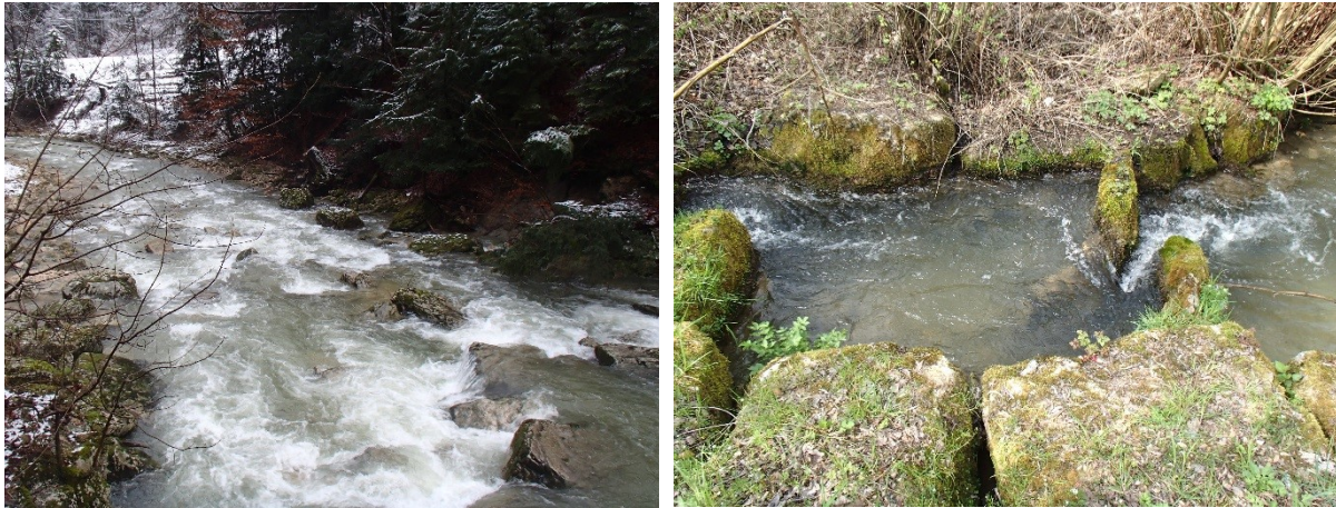
Abb. 9: Durch Hochwässer kann es bei Rampen zum Verschieben/Abschwemmen von Blöcken kommen, was die Fischgängigkeit beeinträchtigen kann. Auch Blöcke naturnaher Aufstiegsanlagen können sich mit der Zeit verschieben (Aquarius)
