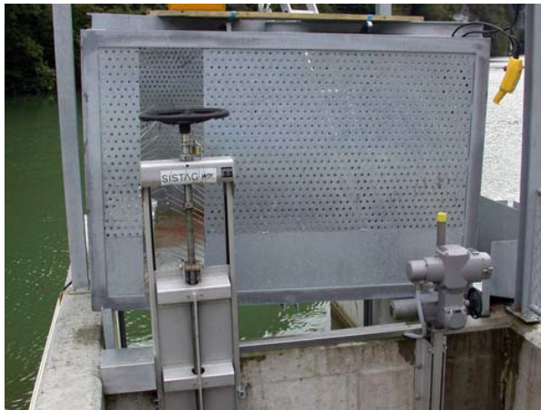
Reuse gehoben (Fischwerk)
