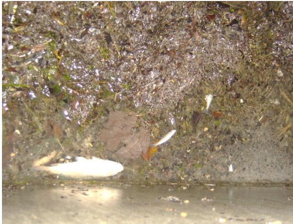
In Container gespültes Rechengut kann mit geringem Aufwand untersucht werden (Aquarius)
