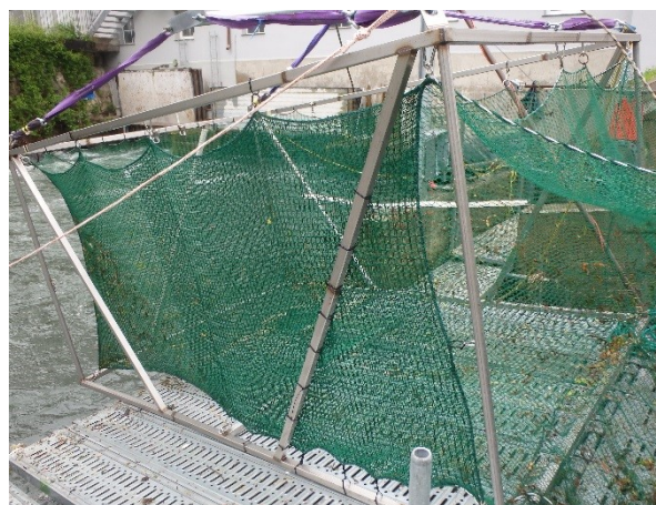
Grossflächige Verstärkung des Netzmateriails aufgrund von Verschleisserscheinungen (Aquarius)
