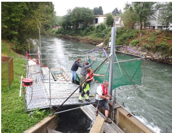
Setzen der Fangvorrichtung mittels Kran (Aquarius)
