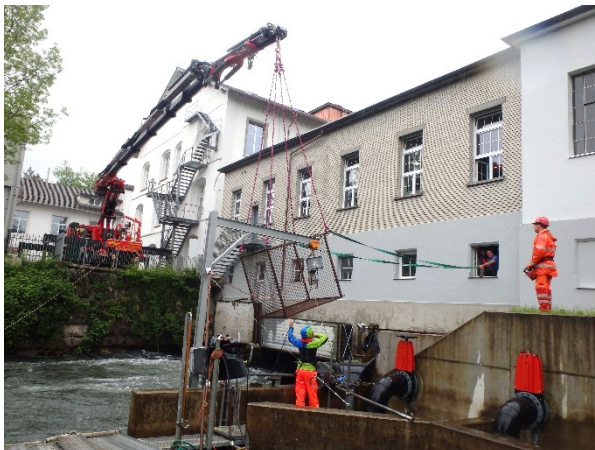
Wird Geschwemmsel über den Bypass abgespült, sind spezifische Auffang- und Befestigungsvorrichtungen notwendig (Aquarius)
