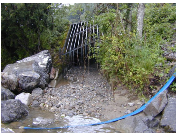
Abb. 6: Ablagerungen im Einstiegsbereich erschweren/verunmöglichen den Einstieg in die Anlage. In naturnahen Anlagen sowie in Ruhebecken kann es zu Feinsedimentablagerungen kommen, die entfernt werden müssen, sofern dadurch der Aufstieg beeinträchtigt wird (Fischwerk/Aquarius)
