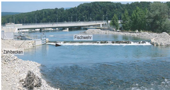
Fischwehr, welches aufsteigende Fische zum Zählbecken leitet (Blick gegen die Fliessrichtung)(Gebler 2013)
