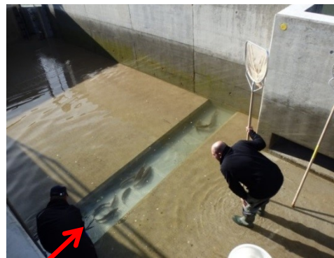
In speziellen Vertiefungen im Zählbecken können Fische besser gefangen werden (Aquarius)
