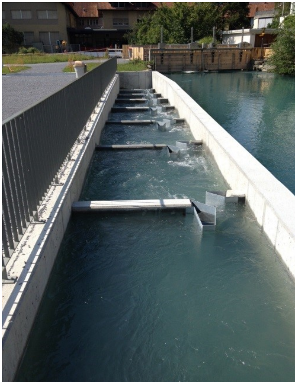
Fischpass Mühleschleuse, Aare
