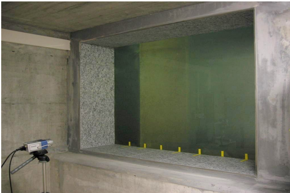
Fischaufstiegskontrollen durch Sichtscheibe mittels Videokamera und Auswertungssoftware FishTick (AJF Kanton GR)
