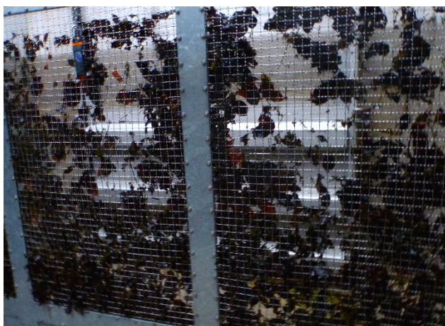
Hoher Laubanfall im Herbst bedingt eine tägliche Reinigung des Absperrgitters (AquaPlus)
