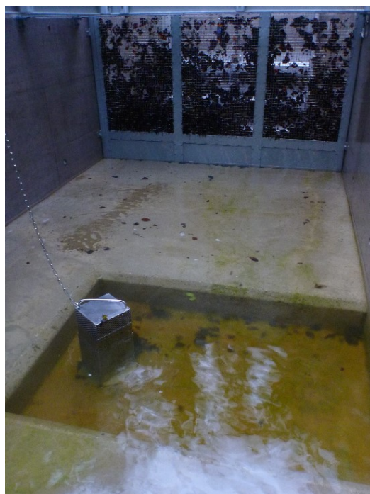
Im Hintergrund ist das Absperrgitter mit geschlossenem Sohlblech sichtbar. Im Vordergrund befindet sich eine Vertiefung mit Ablauf (auf dem Bild verschlossen) (AquaPlus)
