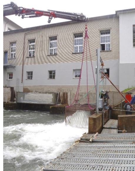
Wird Geschwemmsel über den Bypass abgespült, sind spezifische Auffang- und Befestigungsvorrichtungen notwendig (Aquarius)
