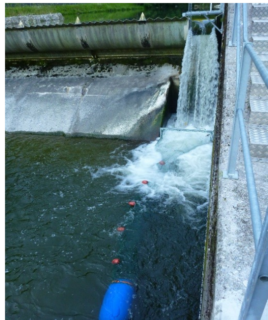
Netzreuse unterhalb Wehraussparung (AquaPlus)
