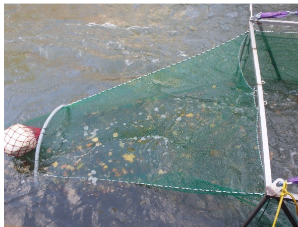
Regelmässige Reinigung bei starkem Geschwemmselanfall (Aquarius)
