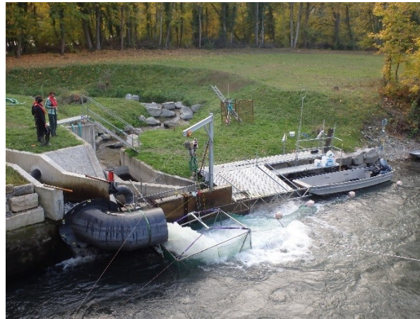
Fangkorb mit angesetzter Netzreuse (Aquarius)
