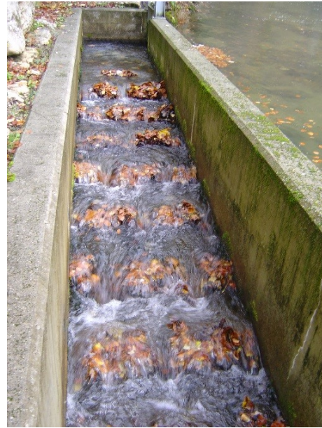
Abb. 4: Verstopfungen mit Geschwemmsel führen zu einer Beeinträchtigung der Hydraulik von Fischpässen. Wird dieses Material nicht regelmässig entfernt, kann dies neben einer Verhinderung des Fischeufstiegs zu einer Beschädigung empfindlicher Anlageteile (z. B. Holzelemente, Borsten) und allenfalls zu Fischverletzungen führen (Aquarius)
