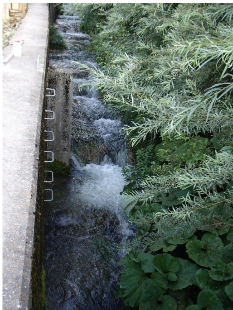
Abb. 3: Anlagen, die von hohen Mauern/Steilwänden umgeben sind, können nur mit grossem Aufwand und entsprechendem Risiko kontrolliert und gewartet werden (Aquarius)
