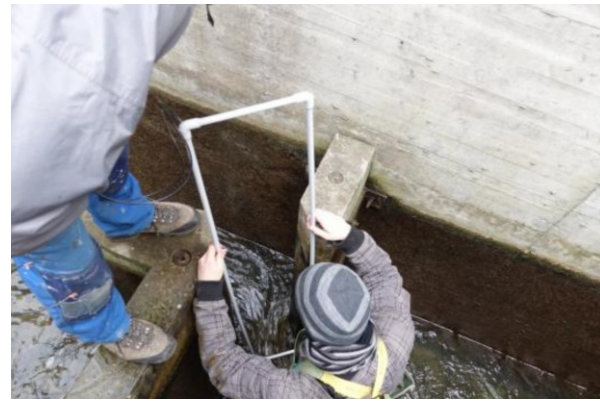
Montage einer Antenne im Schlitz eines Vertical Slot Passes (Peter & al. 2016)
