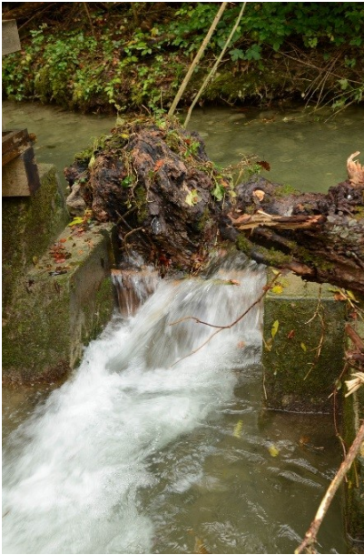
Abb. 4: Verstopfungen mit Geschwemmsel führen zu einer Beeinträchtigung der Hydraulik von Fischpässen. Wird dieses Material nicht regelmässig entfernt, kann dies neben einer Verhinderung des Fischeufstiegs zu einer Beschädigung empfindlicher Anlageteile (z. B. Holzelemente, Borsten) und allenfalls zu Fischverletzungen führen (Aquarius)
