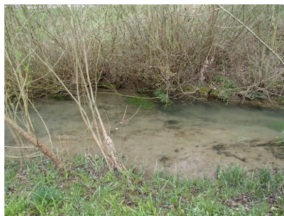
Abb. 6: Ablagerungen im Einstiegsbereich erschweren/verunmöglichen den Einstieg in die Anlage. In naturnahen Anlagen sowie in Ruhebecken kann es zu Feinsedimentablagerungen kommen, die entfernt werden müssen, sofern dadurch der Aufstieg beeinträchtigt wird (Fischwerk/Aquarius)
