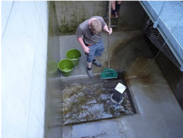
Zählbecken mit Reusenkehle aus Gitterdraht, die ein Zurückschwimmen der Fische in den Schlitzpass erschwert. Verlegung bei hohem Gschwemmselanfall möglich (AquaPlus)
