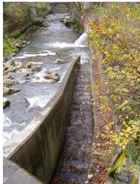
Abb. 3: Anlagen, die von hohen Mauern/Steilwänden umgeben sind, können nur mit grossem Aufwand und entsprechendem Risiko kontrolliert und gewartet werden (Aquarius)
