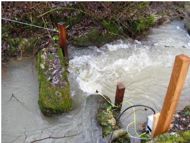
Installation einer Antenne in einem Umgehungsgerinne (AquaPlus)
