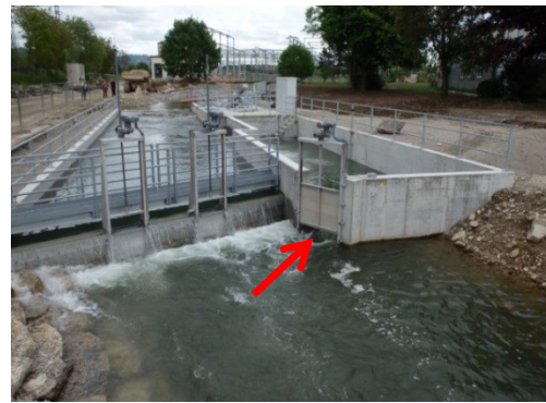
Stromaufwärts schwimmende Fische gelangen in das neben der Aufstiegshilfe angeordnete Zählbecken (Aquarius)
