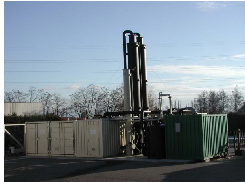
Mehrstufige Grundwasserbehandlung mit katalytischer Abluftreinigung ca. 3 \times 15 \text{ m}^3/\text{h} = 3 \times 250 \text{ l/min}
