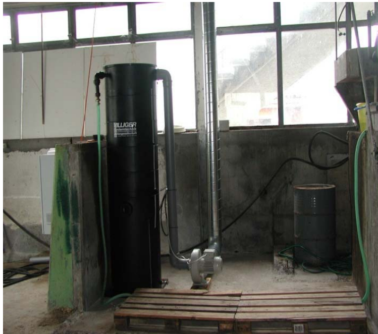
Konzentrierte Förderung aus Quellzone, kleine Anlage ca. 1 \text{ m}^3/\text{h} = 17 \text{ l/min}
