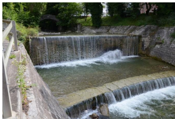
Photo du bas du tronçon direction amont
