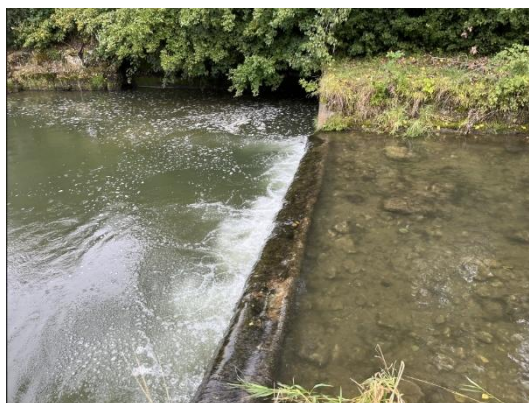
Photo du bas du tronçon direction amont
