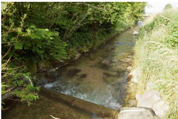
Blick vom oberen Streckenende flussabwärts
