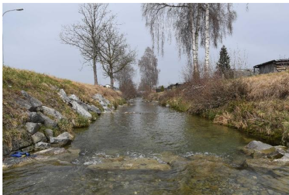
Blick vom oberen Streckenende flussabwärts
