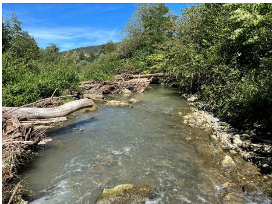
Blick vom oberen Streckenende flussabwärts
