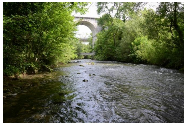
Photo du bas du tronçon direction amont
