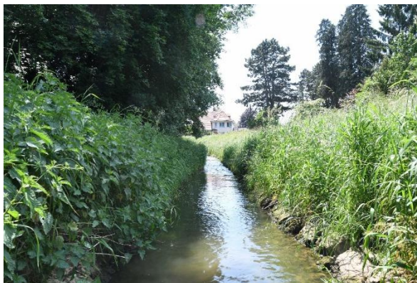
Blick vom oberen Streckenende flussabwärts
