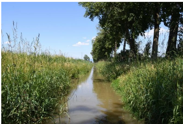
Blick vom oberen Streckenende flussabwärts
