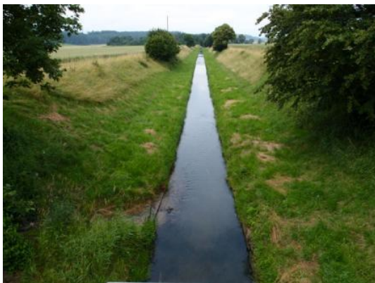
Blick vom oberen Streckenende flussabwärts
