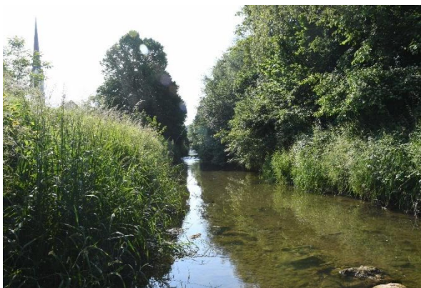
Blick vom oberen Streckenende flussabwärts
