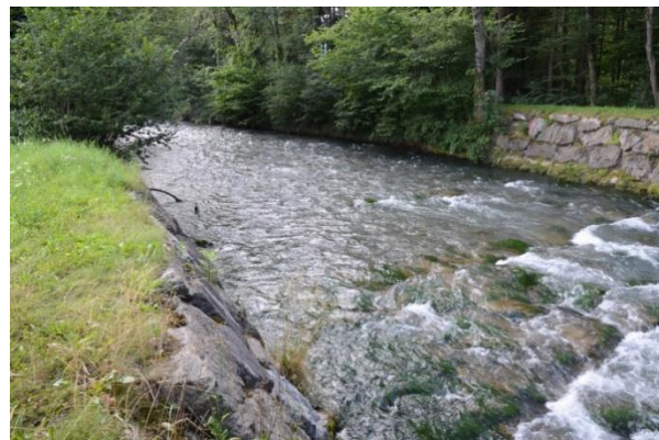
Photo du bas du tronçon direction amont
