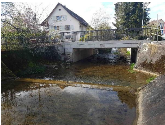
Blick vom oberen Streckenende flussabwärts
