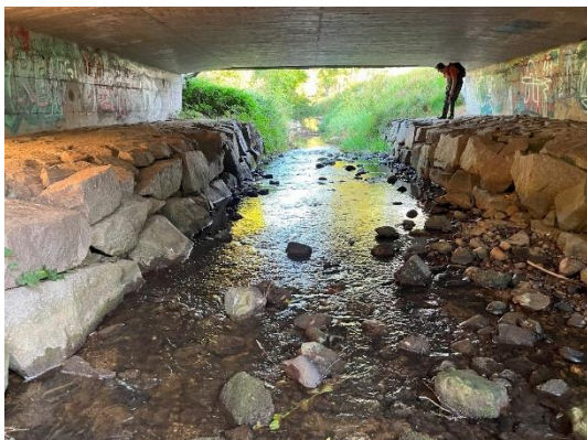
Blick vom oberen Streckenende flussabwärts
