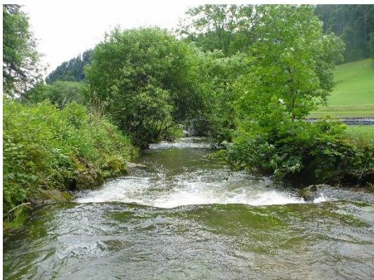
Blick vom oberen Streckenende flussabwärts
