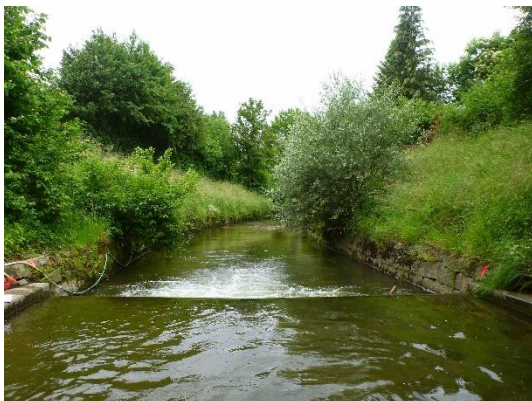
Blick vom oberen Streckenende flussabwärts
