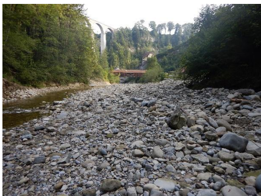
Blick vom oberen Streckenende flussabwärts
