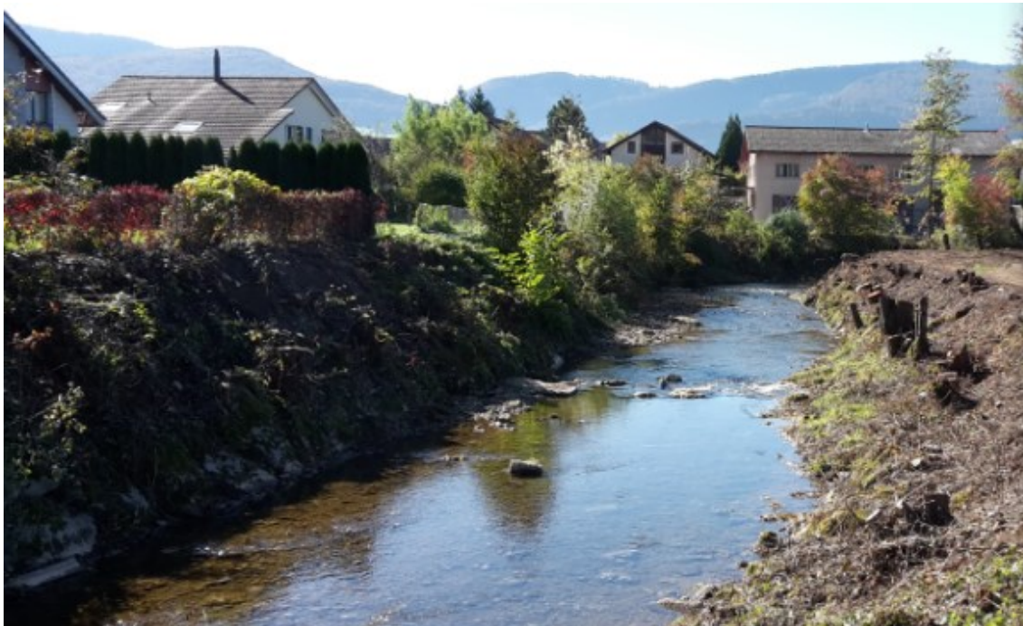
Abbildung 5: Revitalisierter Abschnitt vor Abschluss der Bauarbeiten
