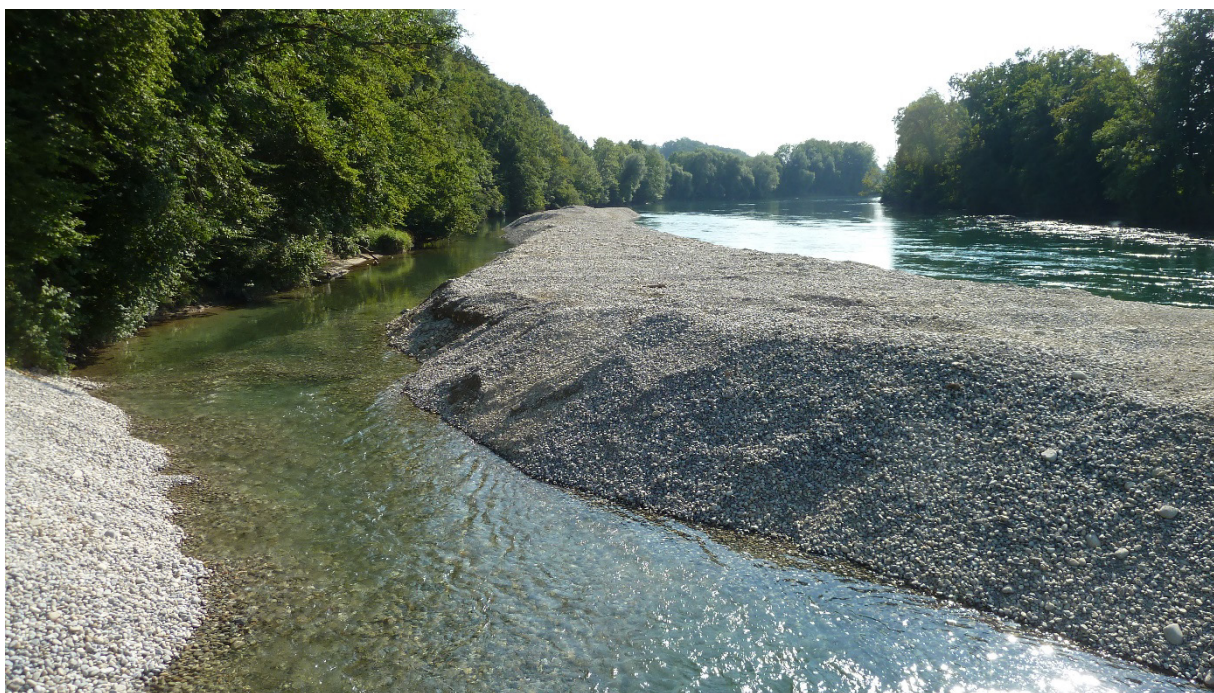
Abbildung 9: Geschiebeschüttung in der Aare etwa 1 Kilometer unterhalb des Kraftwerks Bannwil (Quelle: Kanton Bern)
