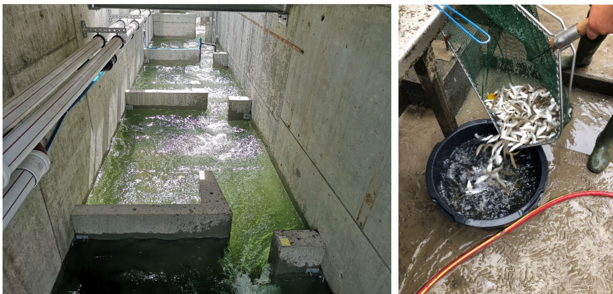
Abbildung 3: Foto: Neue Fischaufstiegshilfe am Kraftwerk Beznau, rechtes Ufer (links), Fischzählung im Rahmen der Wirkungskontrolle (rechts) (Quelle: Ricardo Mendez, Axpo)
