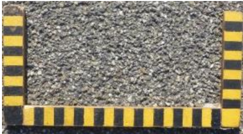
Courfaivre, Rue Chavon-Dessus ACMR4 2012
