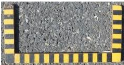
Lausanne, Av de la Vallombreuse Sapaphone 4 2010
