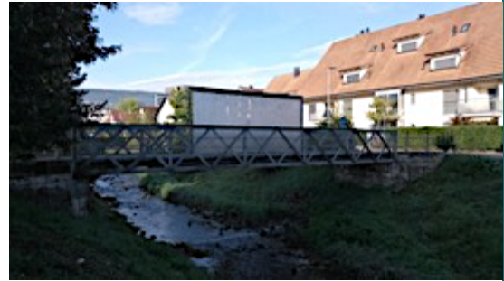
Abbildung 35. Sicht von Standort auf den Wasserschleier auf der Vorstadtbrücke.
