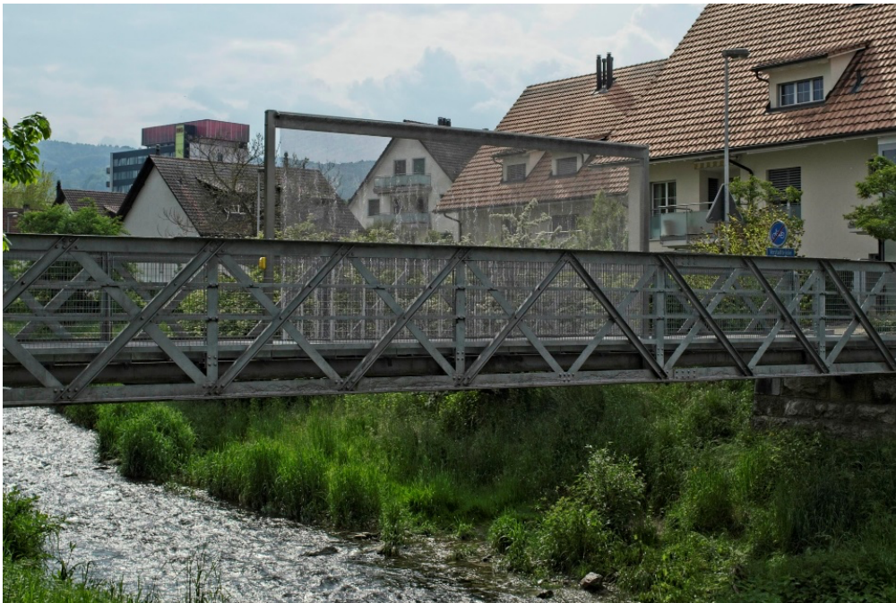
Abbildung 7. Wasserschleier in Dietikon (Bild: Trond Maag)
