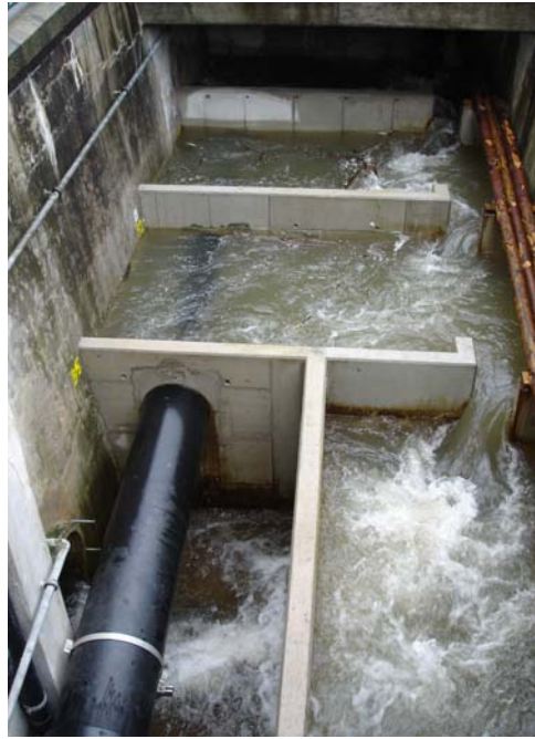
Abb. 5 > Raugerinne-Beckenpass beim Kraftwerk Rheinfelden
