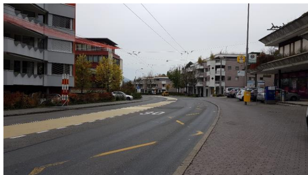
Eingefärbter Mehrzweckstreifen im westlichen Abschnitt
