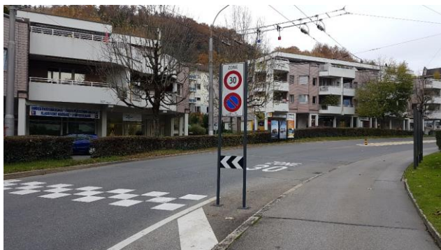
Zoneneingang mit seitlicher Einengung
