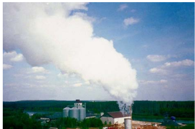
Abb. 8 Uelzen - Die eindrückliche Abgasqualität von ecoDry zeigt der klare Durchblick durch die Abgasfahne am Schornstein
