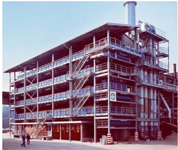
Abb. 18 4-Etagen Bandrockner in Zuckerfabrik mit ca. 30 t/h Wasserverdampfung
