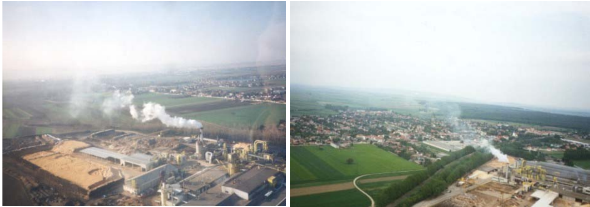
Abb. 3 & 4 Abgasfahne bei Trocknern mit Nasselektrofiltern
