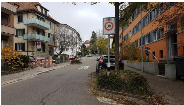
Signalisation „Zone 30“ und seitliche Einengung
