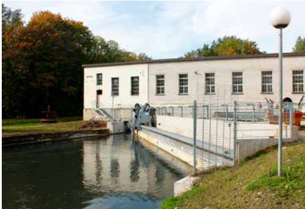
Das Wasserkraftwerk Stroppel an der Limmat verfügt über einen Feinrechen, der wandernde Fische bei ihrem Abstieg sicher an den für sie lebensgefährlichen Turbinen vorbeiführt. Bild: Axpo
