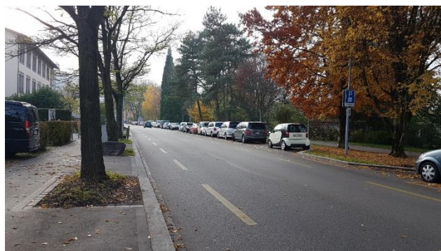
Beidseitige Radstreifen entlang der Strasse
