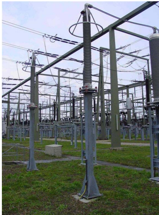
Bild 6.6 220 kV-Überspannungsableiter.
