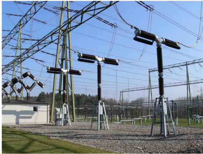
Bild 6.2 Leistungsschalter mit Porzellanisolatoren für 380 kV.
