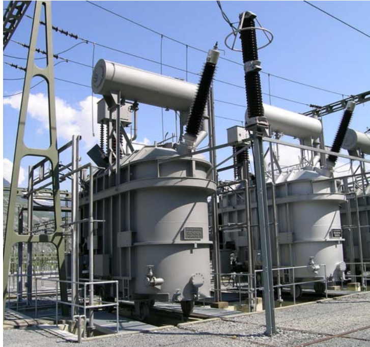
Bild 6.7 220 kV/150 kV-Transformator.
