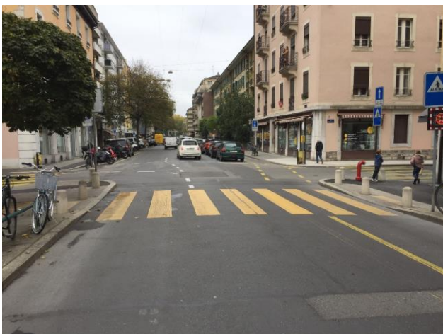
Zwischen dem Trottoir und den Längsparkfeldern geführter Radstreifen
