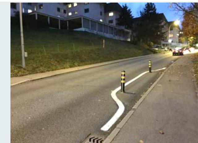
**Abb. 9** Seitliche Einengung bergwärts mit Poller auf Höhe Messtandort durch Betonelement
