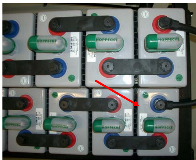
Bild 5.3: UW Münchwil (Axpco AG): Gewellte Plastikeinlagen zwischen benachbarten Batterien verhindern das Gegeneinanderschlagen.
