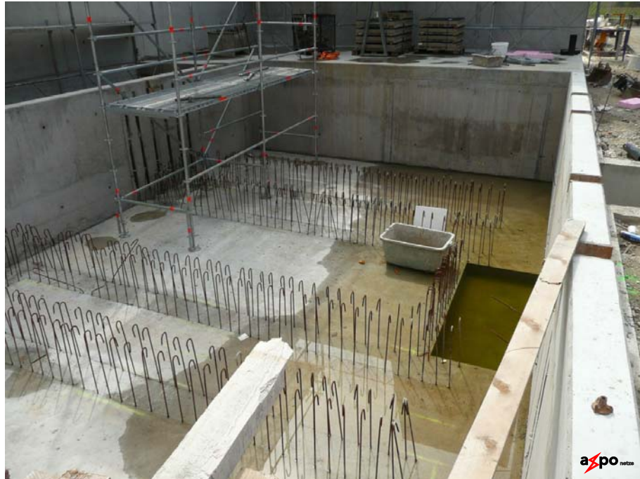
Abbildung 6 Ölauffangwanne mit vorbereiteter Anschlussarmierung für die Schienentragwände
