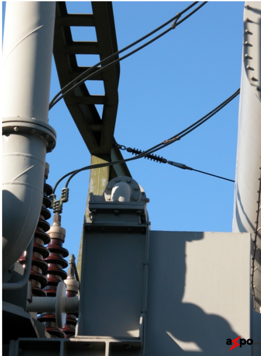
Abbildung 14 Beispiel für "gespannte" Anschlussseile
