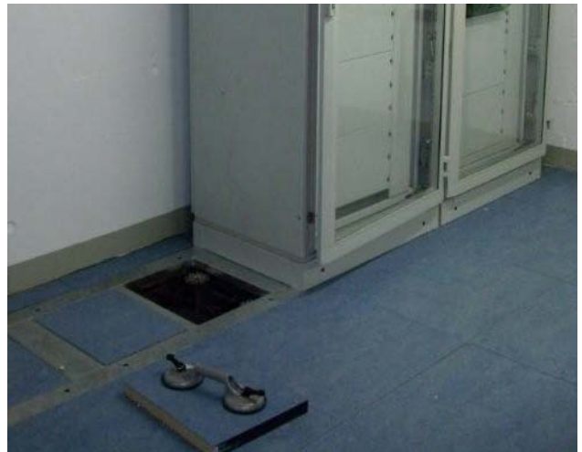
Bild 4: Bodenrahmen zur Verankerung von Elementen
