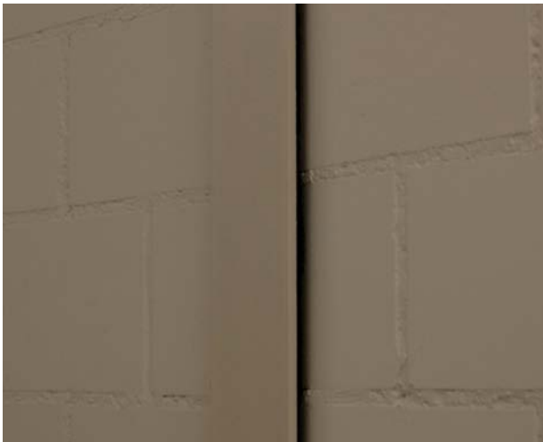
Bild 3: Stahlträger zur Sicherung der MW-Trennwände
