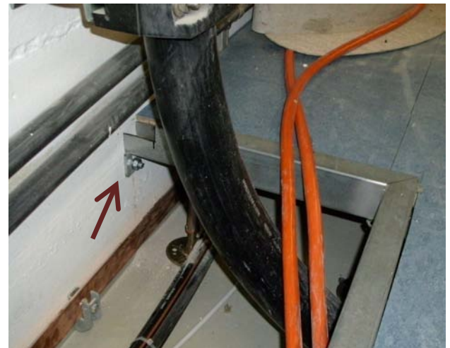
Bild 6: Verdübelung in die massive Wand
