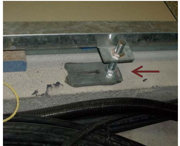
Bild 9: Befestigung Bodenrahmen (150 kV-Steuerschrank)
