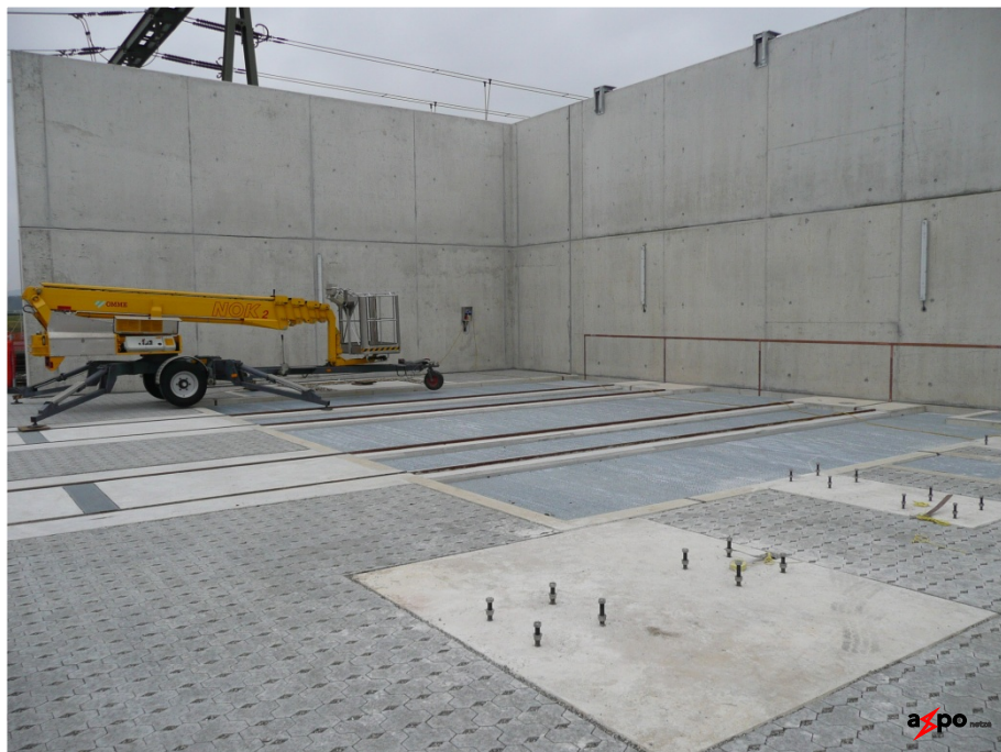
Abbildung 2 Standplatz für einen 160-MVA-Transformator 220/110 kV, NE 2
