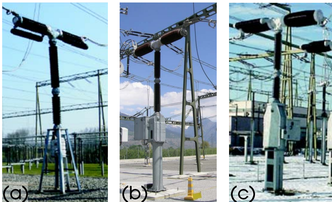
Bild 3.1: Untersuchte Leistungsschalter: (a) ABB ELF SP6-2 (380 kV), UW Breite, (b) Alstom HGF 115/2 (380 kV), UW Chamoson, (c) Sprecher HGF 214/2 (220 kV), UW Breite.
