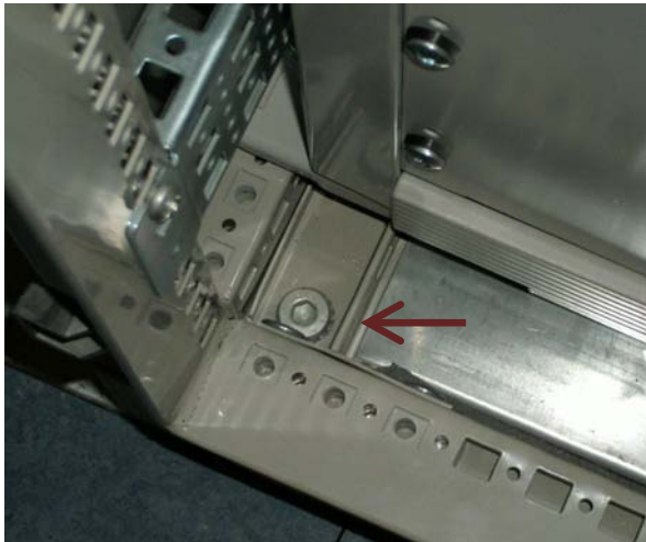
Bild 8: Verschaubung des Schrankes auf den Bodenrahmen
