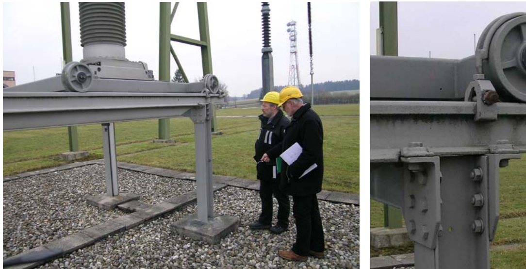
Bild 3.3: Nahansichten der Verankerung der Messgruppe in Bild 3.2a; kritisch sind die Klemmen in Bildmitte des rechten Bildes, welche die Schiene halten.
