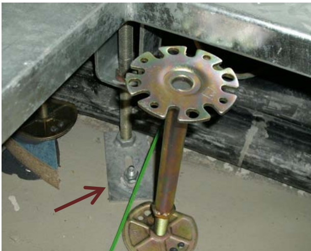
Bild 5: Verdübelung in den Betonboden
