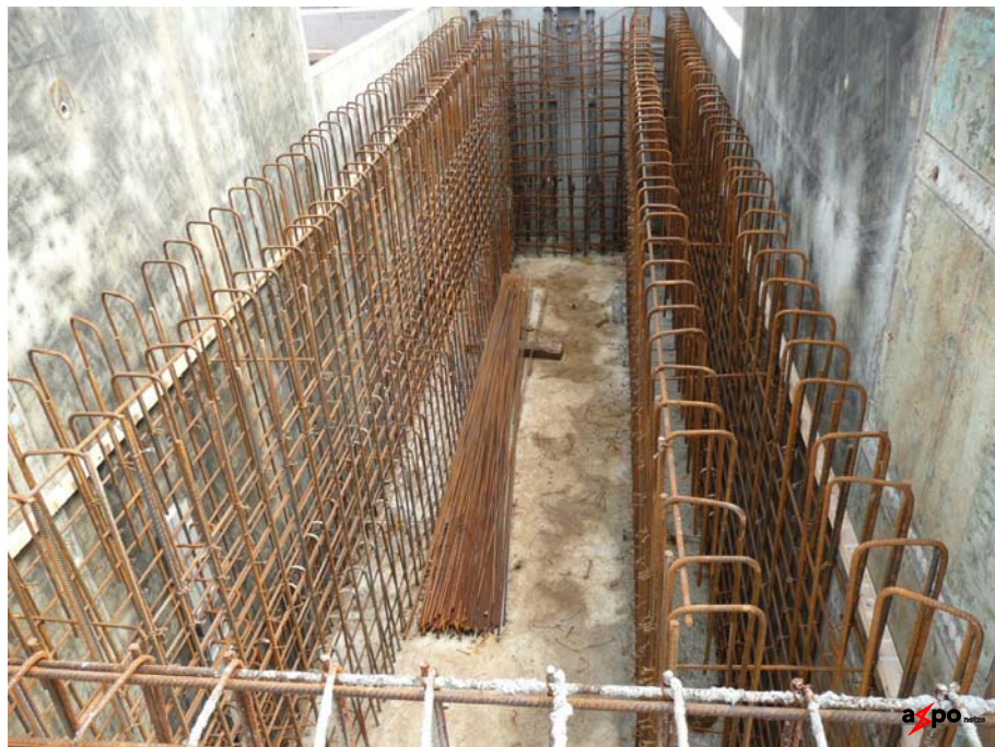
Abbildung 7 Armierung und äussere Schalung der Tragmauern
