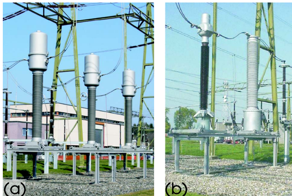
Bild 3.2: Untersuchte Apparate: (a) Messgruppe Ritz KSKEF 450, UW Breite, (b) Kopfstromwandler Haefely IOSK 420, UW Breite.
