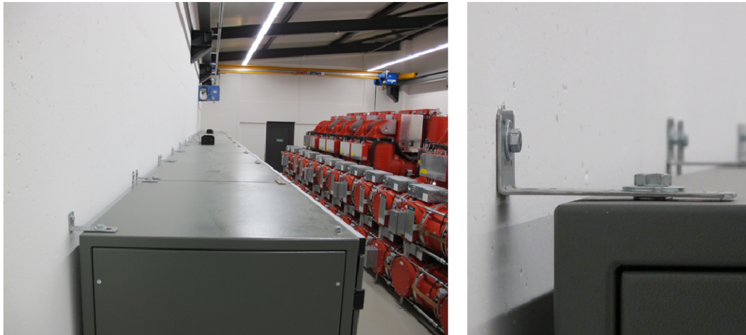
Bild 5.4: Verankerung von Steuerschränken, die längs einer massiven Wand stehen, mit Hilfe einfacher Winkel und Dübel (Axpog AG).
