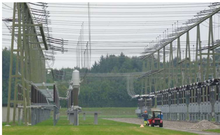
Bild 4.4: Links unten: Relativ straffe Leiterverbindungen zwischen Messgruppen und Schwenktrenner (220 kV) im UW Breite.
