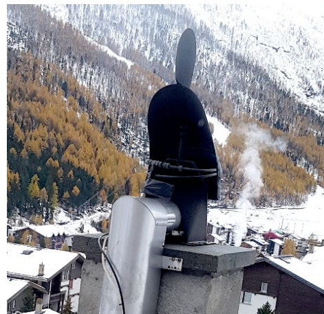
Abbildung 16: Metall, rund, halb offen (drehbarer Kaminhut)
