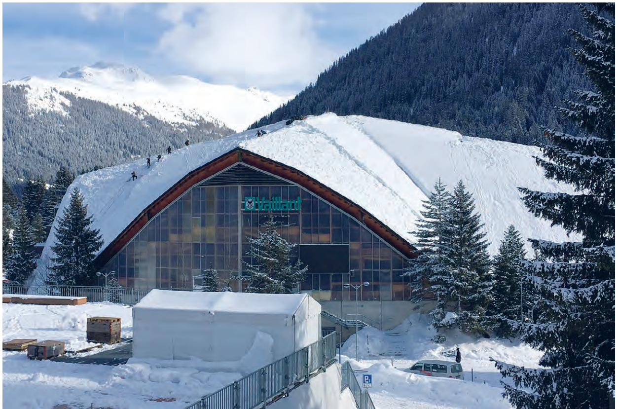
Abb. 37: Anfang Februar 2018 wurde grossflächig Schnee vom Dach des Eisstadions in Davos abgetragen, um im Falle von weiteren grossen Schneefällen Probleme mit der Statik des Tragwerkes zu verhindern. Bei der Räumung eines Daches von Schnee ist die Statik des Dachtragwerkes zu beachten. Ein einseitiges Abtragen oder lokale Schneeanhäufungen sind zu vermeiden. Die Personen auf dem Dach des Eisstadions waren mit Seilen gesichert. Dachsneeräumungen dürfen nur durch ausgebildetes Personal durchgeführt werden (Foto: SLF/ S. Margreth).
