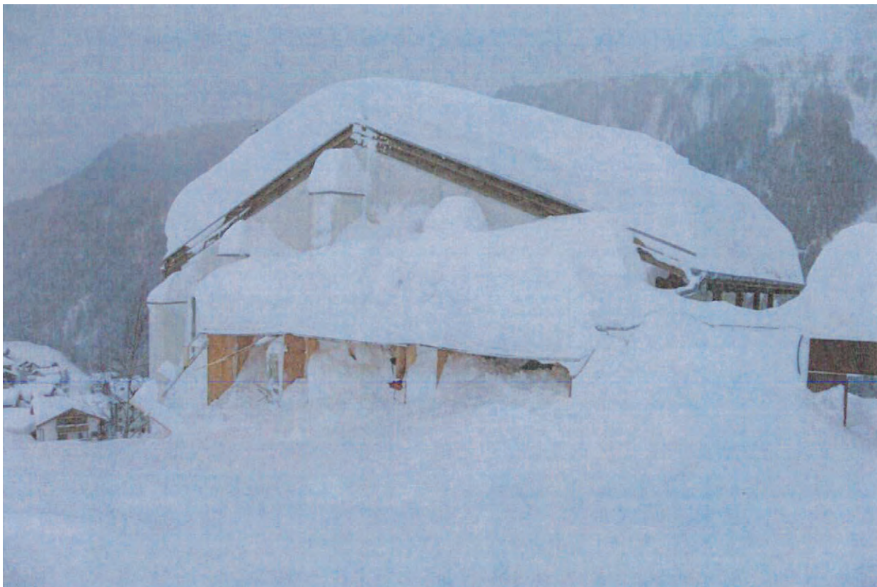
Abb. 102: Ansicht des obersten der von der Lawine erfassten Gebäude (Foto: Fam. Moser-Jenal).
