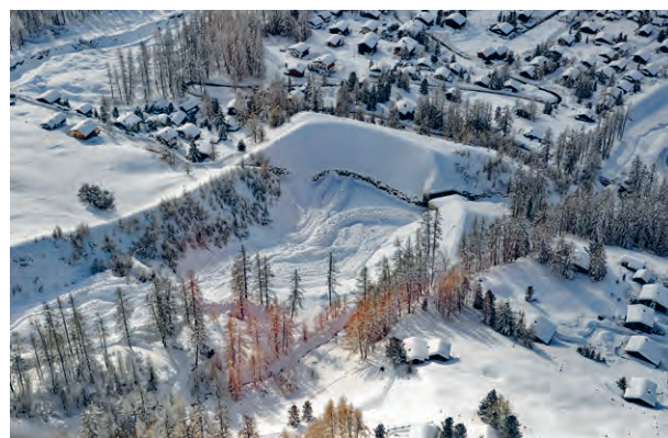
Abb. 127: Beim Lawinendamm des Torrent du Perrec in Zinal, Wallis, erreichte die Lawine knapp den Dammfuss. Hinsichtlich Wirkung oder Bemessung des Dammes lässt sich keine Aussage machen (Foto: P. Stoebener, 10.01.2018).
