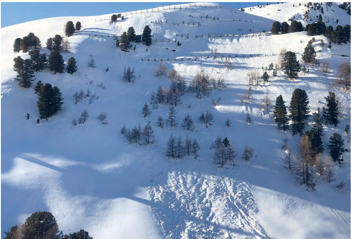
Abb. 89: Eine Lawine brach in den Schneesetzen oberhalb Meiden unterhalb der obersten Werkreihe an und durchfloss die gesamte Verbauung. Die Lawine lief im Jungwald unterhalb der Verbauung aus, ohne Schaden anzurichten (Foto: Rinaldo Hugo, 29.01.2018).
