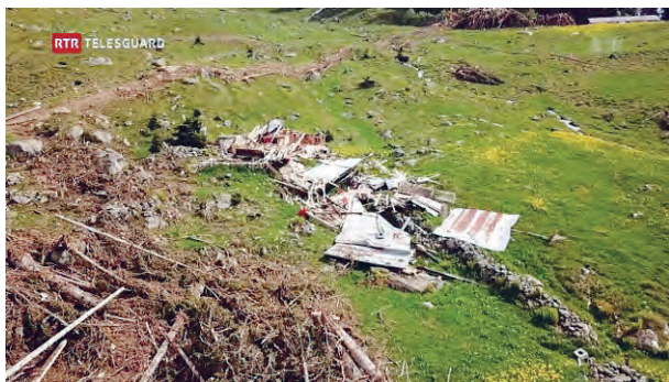
Abb. 80: Die zwei Alphütten der Alp da Schlans Sut wurden vollständig zerstört (Foto: Radiotelevision Svizra Rumantscha, Sommer 2018).
