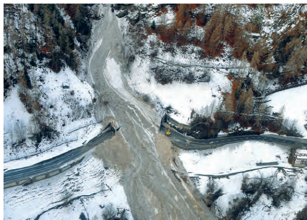
Abb. 133: Bei Eisten, Saastal (VS), überfloss die Putzloiwna im Januar 2018 beide Galerieportale (Foto: P. Stoeber, 10.01.2018).
