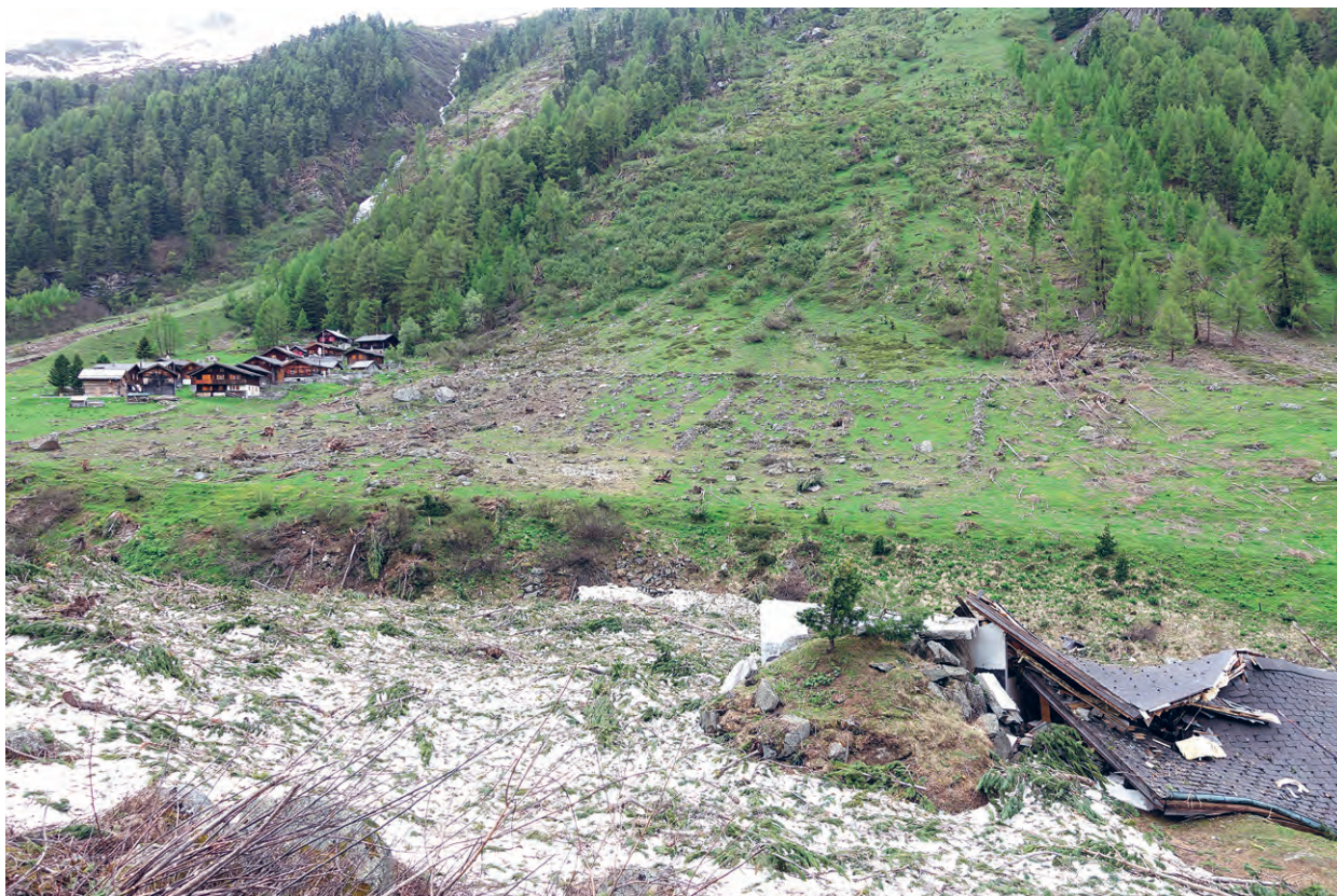
Abb. 85: Das unterhalb des Weilers Blüomatt zerstörte Chalet befand sich am Gegenhang im Randbereich des Lawinenauslaufs sowie am Rand des roten Gefahrengebiets (Foto: SLF/K. Winkler, 31.05.2018).
