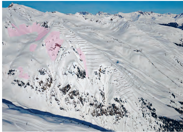
Abb. 111: Stützverbauung Schiachhorn, Davos (GR), ausserhalb der Verbauung brachen einige grosse Lawinen (Grösse 4) an, die im Schiatobel ausliefen. In der Verbauung konnten keine Lawinenanbrüche festgestellt werden (Foto: M. Phillips, 24.01.2018).
