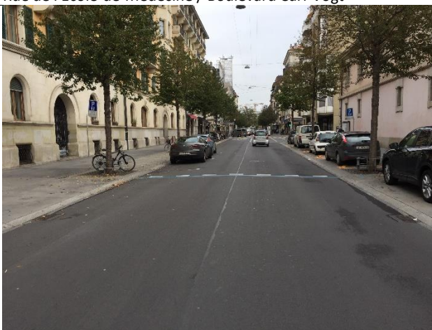
Längsparkfelder sind teilweise auf der Strasse angeordnet und sind damit auch eine seitliche Einengung
