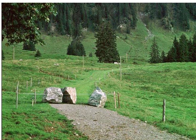
Abb. 21 > Wirksame Methode zur Vermeidung von Fremdverkehr auf einer Strasse, die nur periodisch der forstlichen Nutzung dient
