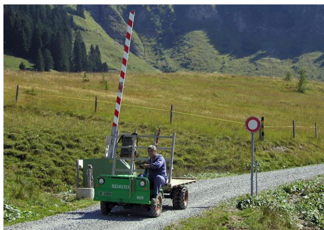
Abb. 22 > Eine wirksame Methode zur Vermeidung von Fremdverkehr auf einer vielgenutzten Alpstrasse: Selbstschliessende Barriere
