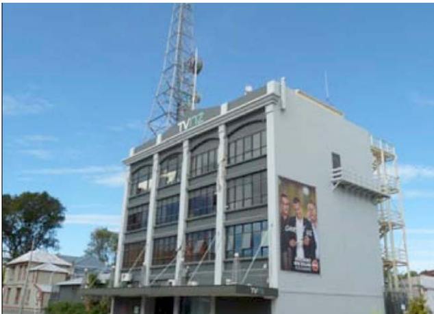
Beschädigtes TV-Gebäude mit Telefonzentrale (Christchurch, 2011) 6
