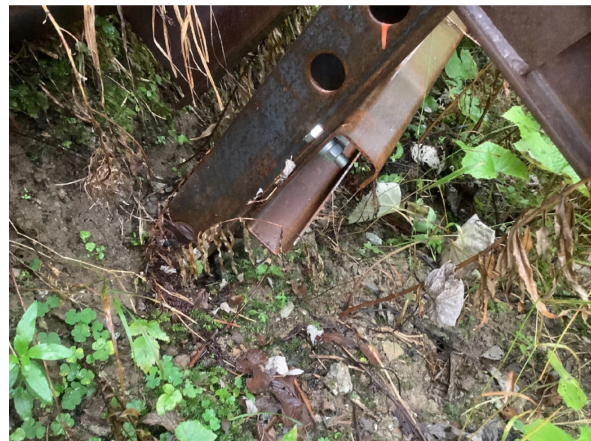
Abbildung 29: Stahlstützwerk Nr. 2: a) Rostebene (links); b) Foundation (rechts).
