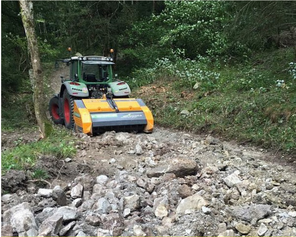
Abbildung 23: Beispiel für eine Waldstrasse, wo im Rahmen des baulichen Unterhalts die Tragschicht erneuert und verstärkt wird (Quelle: Kt. SG).
