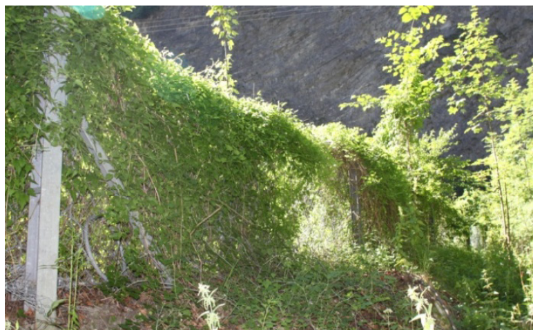
Abbildung 16: Beispiel für ein Schutzbauwerk, wo betrieblicher Unterhalt notwendig ist.
