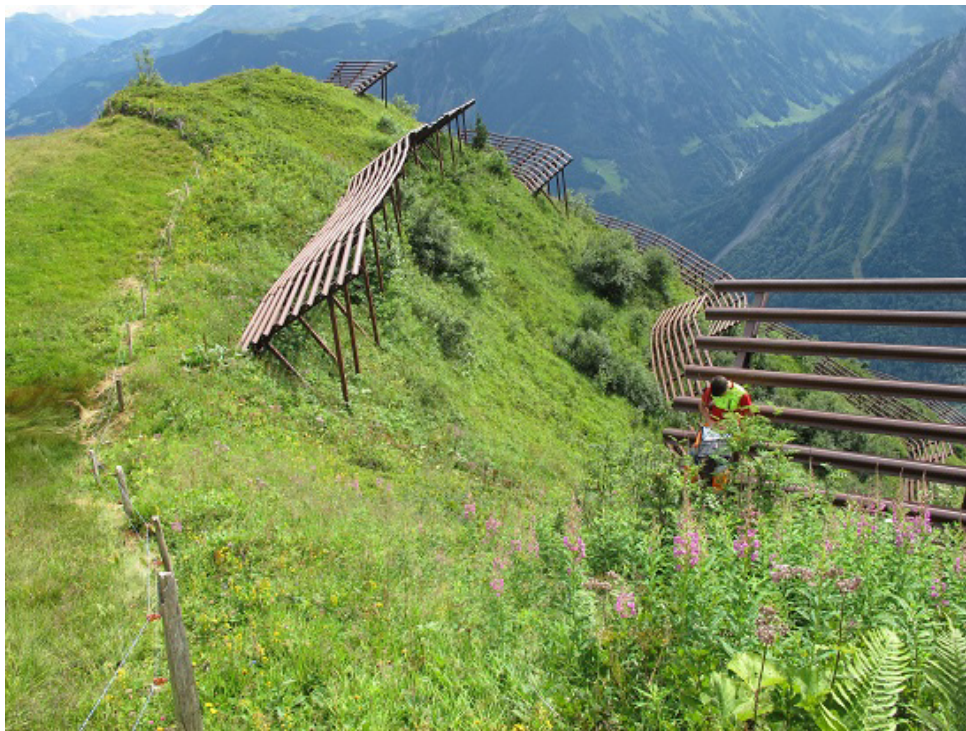
Abbildung 13: Beobachtung einer permanenten Lawinenverbauung. Der Beobachtungsstandort ist ein Wanderweg oberhalb der Anrisslinie.
