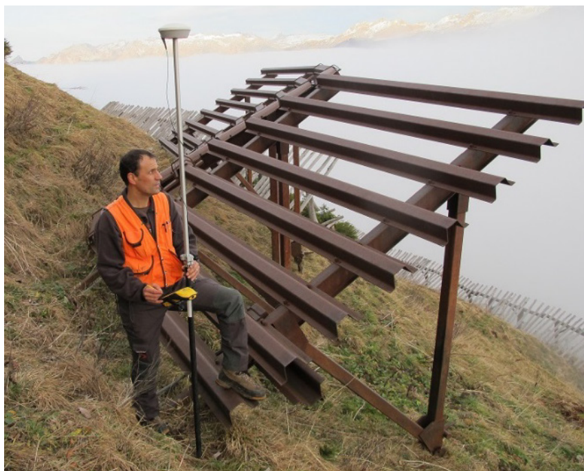
Abbildung 11: Erfassung der Liniengeometrie einer Lawinverbauung im Anrissgebiet Rietstöckli / GL mit satellitengestützter Lagebestimmung.
