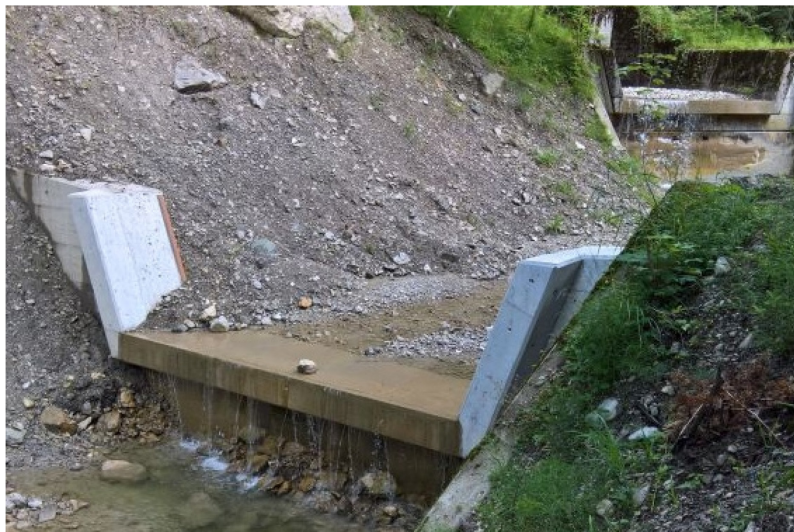
Abbildung 17: Beispiel für ein Schutzbauwerk, wo baulicher Unterhalt erfolgt ist (Quelle: Kt. SG).
