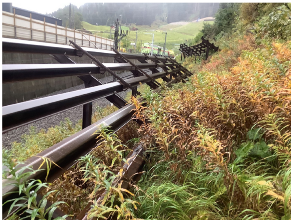
Abbildung 29: Stahlstützwerk Nr. 2: a) Rostebene (links); b) Foundation (rechts).
