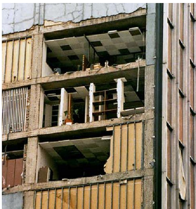
Abb. 2.5.3 > Versagen aus der Ebene einer vorgehängten Fassade
