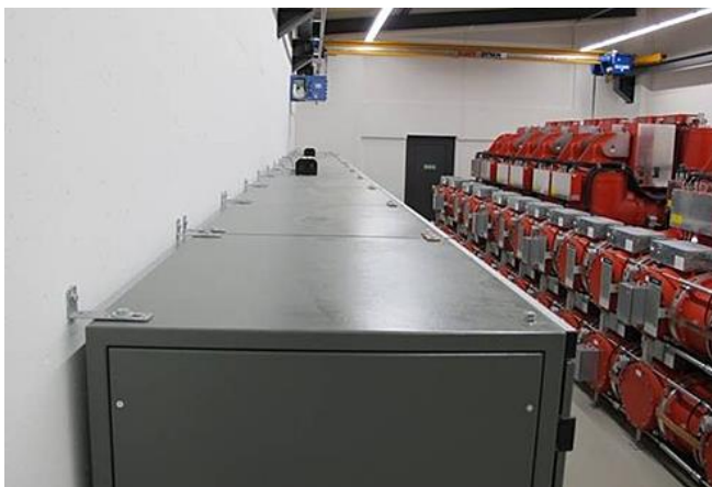
Abb. 2.13.6 und 2.13.7 > Sicherung von Schränken an der Wand
