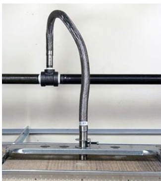
Abb. 2.12.3 > Flexible Abzweigung von Hauptleitung
