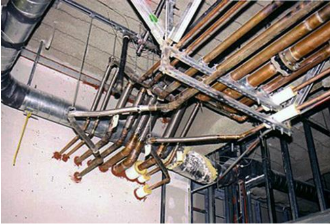
Abb. 2.18.10 > Flexible Verbindungen bei Wanddurchbrüchen, Aussteifung von Leitungstrasse
