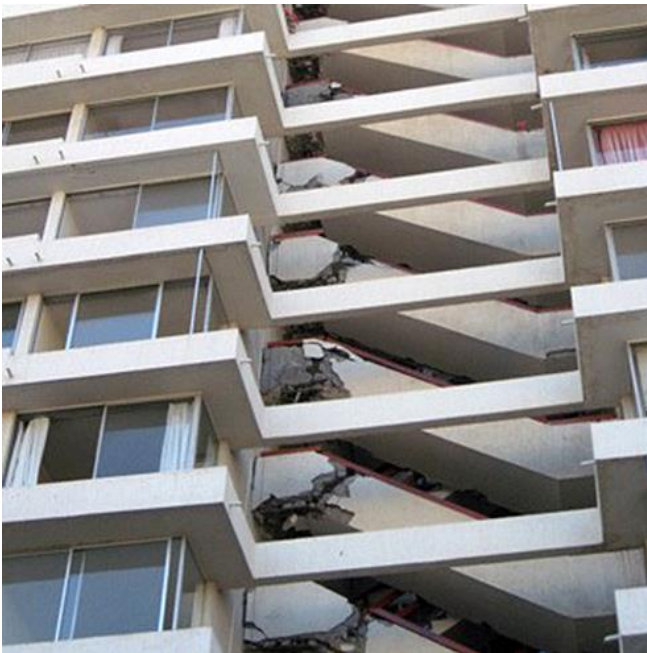
Abb. 2.7.1 und 2.7.2 > Druckdiagonalen im Treppenlauf
