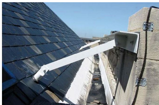
Abb. 2.6.6 > Massnahmen für Brüstungen auf dem Dach
