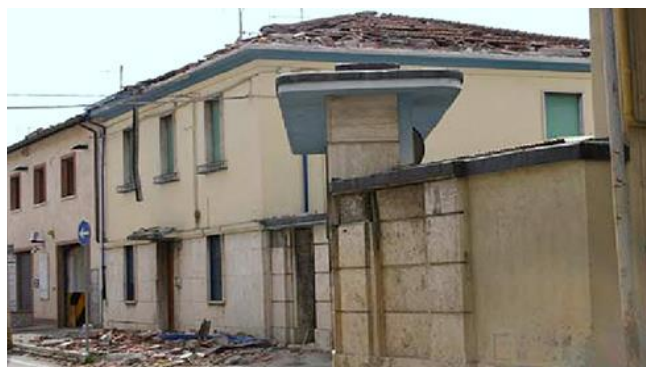
Abb. 2.10.2 > Heruntergefallene Dachziegel
