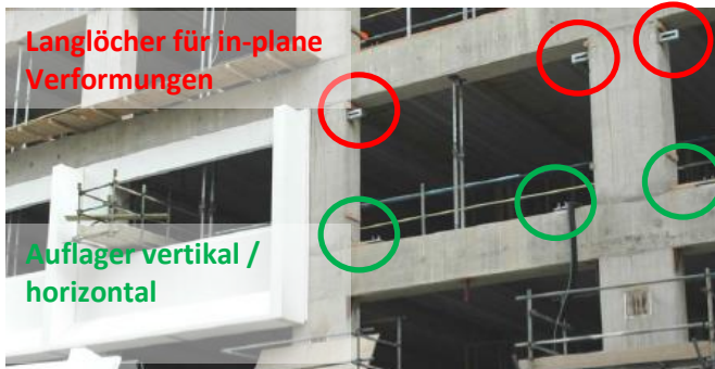
Abb. 2.5.5 > Befestigung von Fassadenelementen mit Langlöchern
