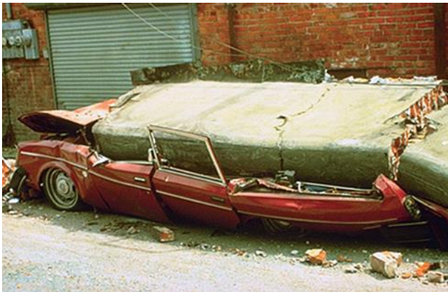
Abb. 2.6.1 und 2.6.2 > Versagen infolge Trägheitskräften quer zur Brüstungsebene
