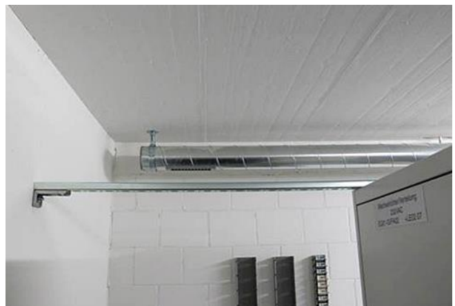
Abb. 2.13.5 > Verankerung von freistehenden Schrankeinheiten
