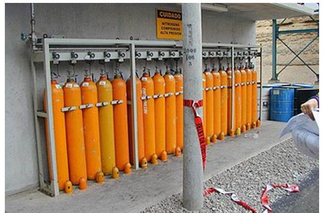
Abb. 2.17.8 > Befestigung von Zylinderflaschen
