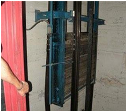
Abb. 2.19.1 > Führungsschiene durch Gegengewichte verbogen
