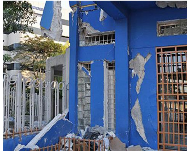
Abb. 2.8.3 > Schäden an Verglasung mit Glasbausteinen
