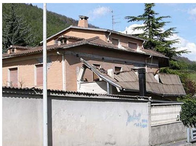
Abb. 2.9.2 > Eingestürztes Vordach
