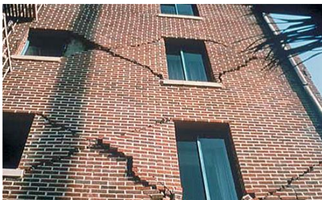
Abb. 2.5.1 > Kreuzrisse zwischen Fenstern
