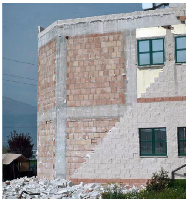
Abb. 2.5.4 > Einsturz einer vorgemauerten Fassade
