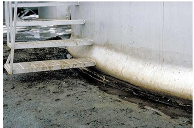
Abb. 2.17.4 > Ausgebeulte Tankwand (sog. «Elefantenfuss»)
