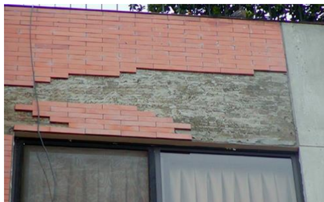
Abb. 2.5.2 > Ablösung von geklebten Elementen
