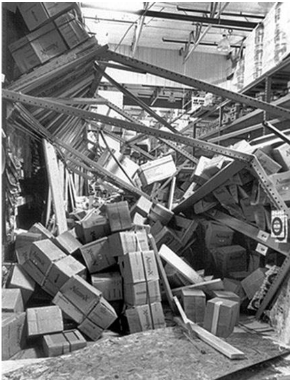
Abb. 2.23.1, 2.23.2 und 2.23.3 > Eingestürzte Hochregallager
