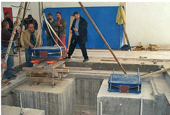
Abb. 2.25.6 und 2.25.7 > Schwingungsisoliertes Fundament für eine Skulptur
