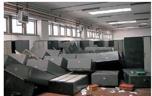
Abb. 2.22.5 und 2.22.6 > Kippen mehrerer Regalreihen infolge des Domino-Effekts
