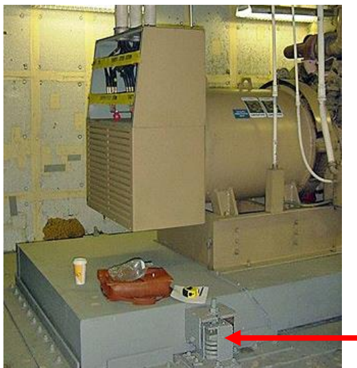
Abb. 2.20.5 > Feder mit vertikaler Sicherung, Puffer zur Begrenzung der Horizontalverschiebungen
