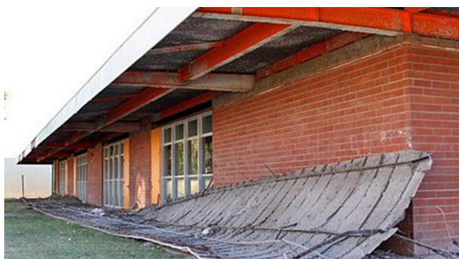
Abb. 2.10.3 und 2.10.4 > Abgelöste Deckenuntersicht und Abplatzungen in Verputz
