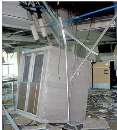
Abb. 2.16.2 > Ungenügend ausgesteiftes Element
