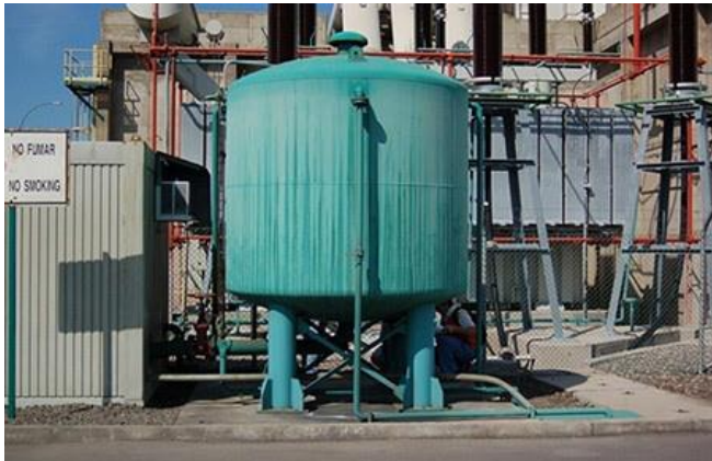
Abb. 2.17.5 > Aussteifung von aufgeständerten Tanks
