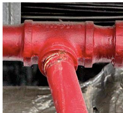
Abb. 2.18.3 > Schaden bei Verzweigung
