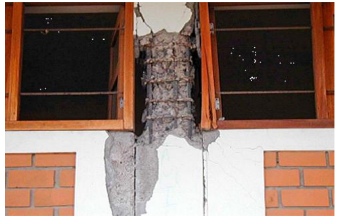
Abb. 2.4.2 > Schubbruch in kurzer Stütze bei Mauerwerksausfachung
