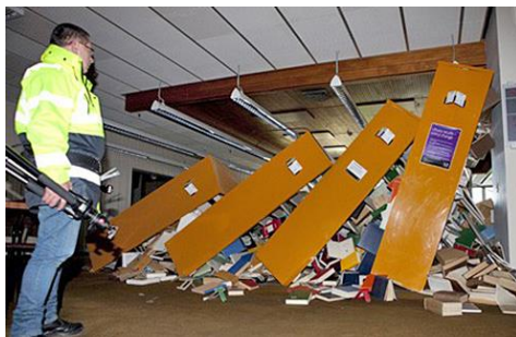
Abb. 2.22.5 und 2.22.6 > Kippen mehrerer Regalreihen infolge des Domino-Effekts
