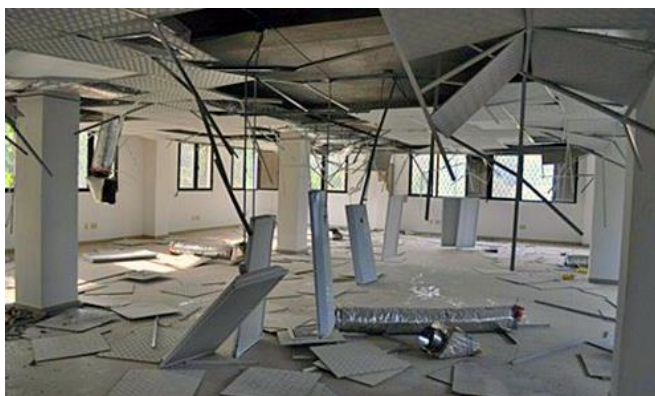
Abb. 2.15.1 und 2.15.2 > Absturz von Beleuchtungselementen
