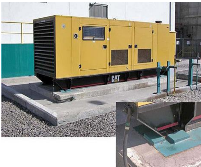
Abb. 2.16.7 > horizontaler Anschlag bei Generator
