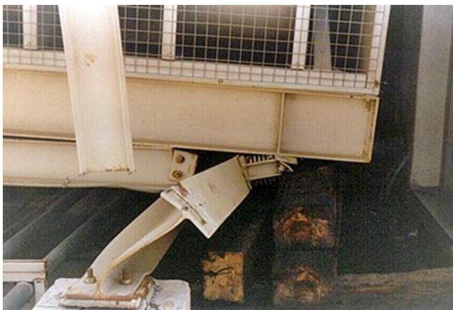
Abb. 2.16.3 und 2.16.4 > Gleitverschiebungen/Instabilitäten
