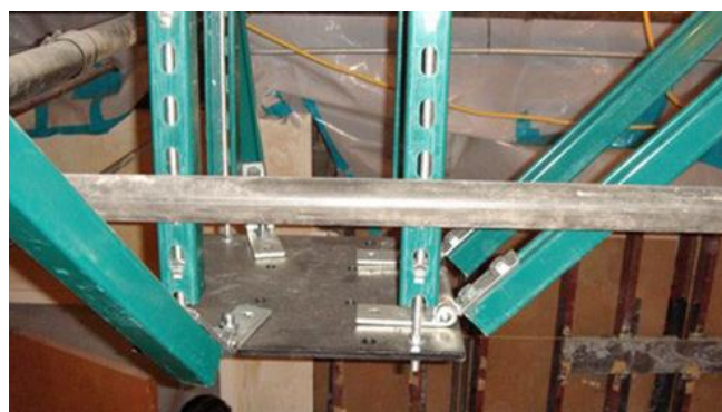
Abb. 2.15.4 > Aussteifung schwerer Leuchtkörper
