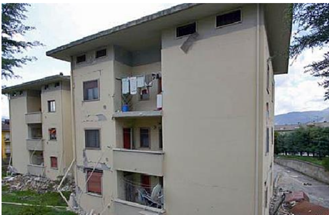
Abb. 2.6.3 > Brüstung im oberen Geschoss herausgefallen
