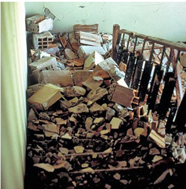
Abb. 2.7.3 > Trümmerteile versperren den Treppenlauf
