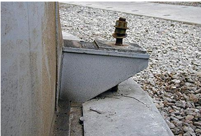
Abb. 2.17.3 > Beschädigte Verankerung
