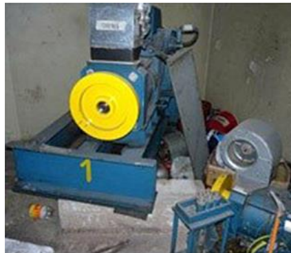
Abb. 2.19.2 > Ungenügend befestigte Antriebseinheit
