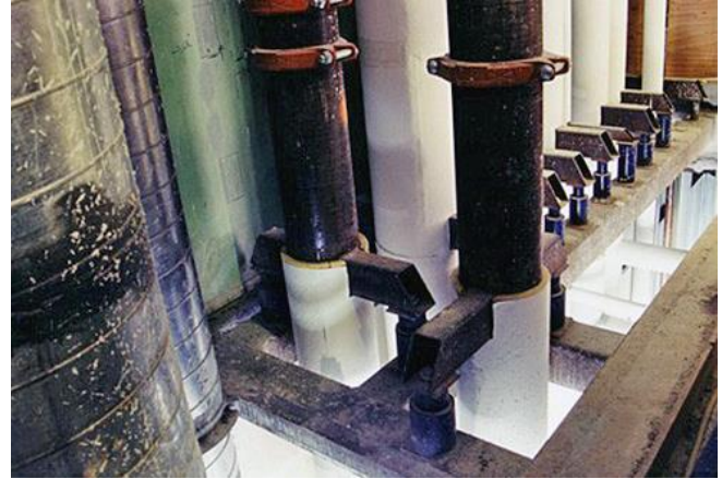
Abb. 2.18.11 > Lagerung von Steigleitungen bei Deckendurchbrüchen
