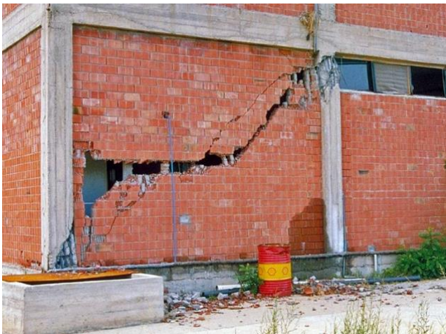
Abb. 1.4: Schäden an Stützen durch Mauerwerksausfachung, Türkei Erdbeben 1998
