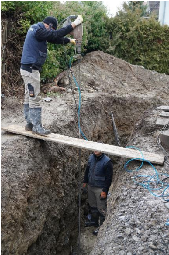
Bohrung Lanzen für Injektion
