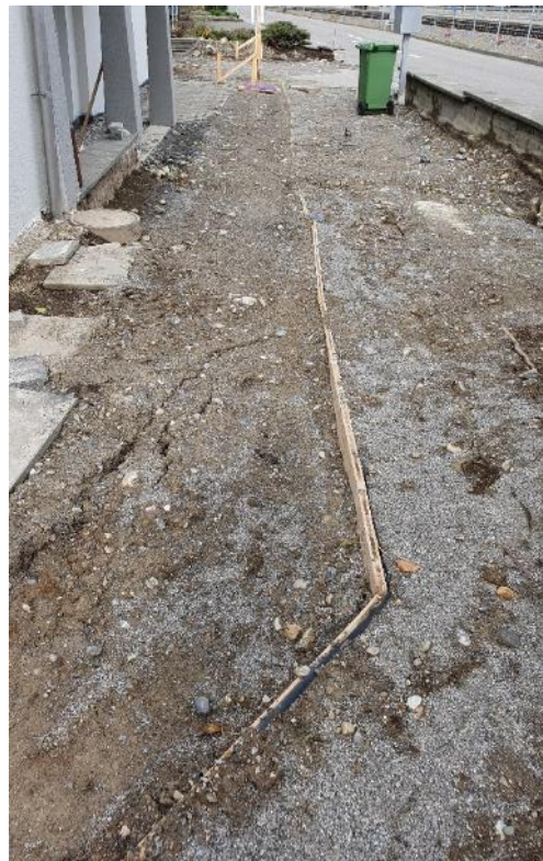
Verfüllter Bodenschlitz Zentraler Bereich
