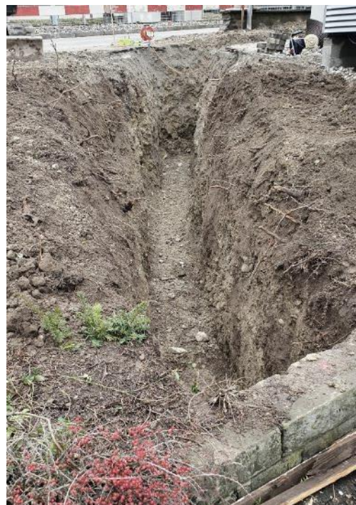
Offener Bodenschlitz Westbereich
