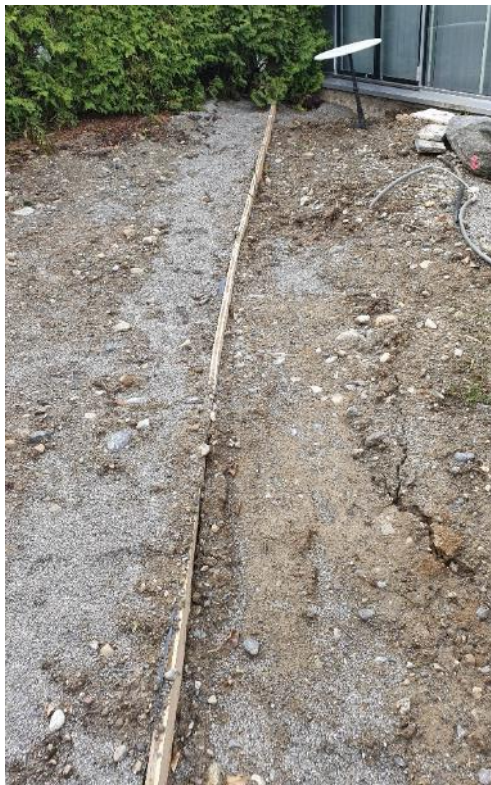
Verfüllter Bodenschlitz Ostbereich
