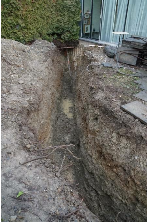
Offener Bodenschlitz Ostbereich
