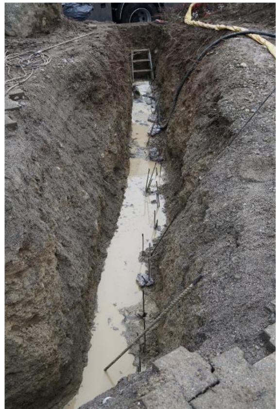
Injektionsreihe im Westbereich
