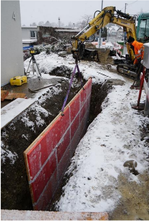
Einbringen Elastormatten auf Schaltafel
