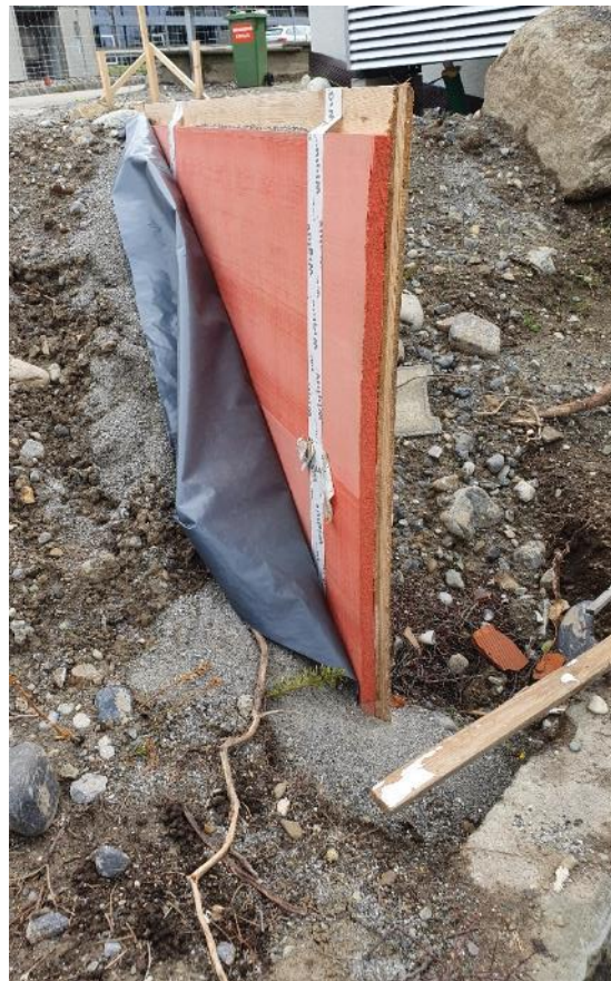
Verfüllter Bodenschlitz Westbereich bei Mauer
