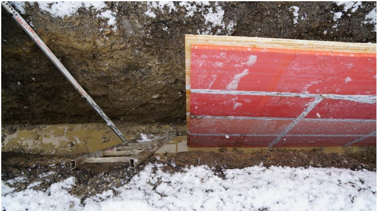
Elastormatten im offenen Bodenschlitz auf dem Injektionskörper (vor Abdeckung mit Plastikfolie)
