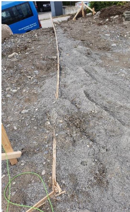
Verfüllter Bodenschlitz Westbereich
