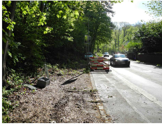
Abbildung 5.28: Foto des Messtandortes Tobelhofstrasse. Blick in Fahrtrichtung Dübendorf (aufwärts).
