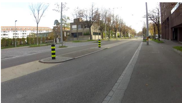
Querungshilfe mit Mittelinsel
