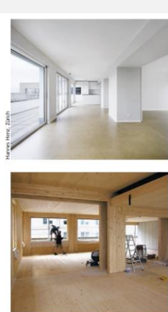
Abbildung 119: Gebäudetyp 10 Leichtbau – Stützträgersystem Holz, Aussenwände in Holzrahmenbau.
