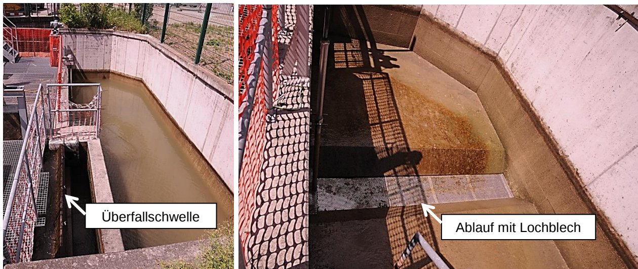
Abb. 58: Zählbecken des Raugerinne-Beckenpasses Wyhlen (D) in geflutetem (links) und abgelassenem Zustand (rechts)
