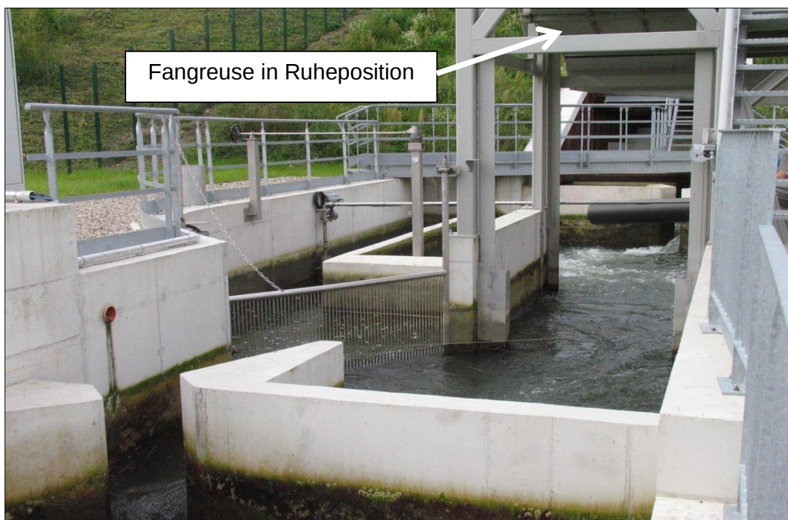
Abb. 133: Aufteilung des Betriebsabflusses im Schlitzpass Gambenheim, so dass die exponierte Fangreuse (im Bild rechts) nur von einem Teilabfluss durchströmt wird
