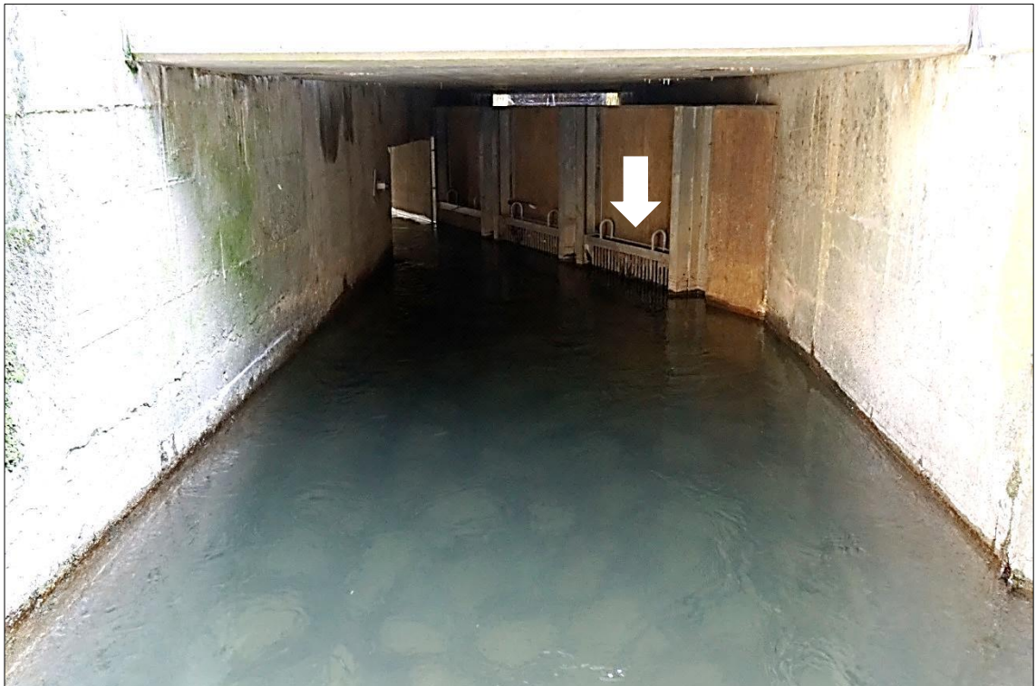
Abb. 125: Blick in den gelenzten Kanal des wehrseitigen Einstiegs in den Schlitzpass stromauf von HDX-Antenne Nr. 168 mit einer mit einem Rechen (Pfeil) gegen ein Einschwimmen gesicherten Zusatzdotation (nicht in Betrieb)
