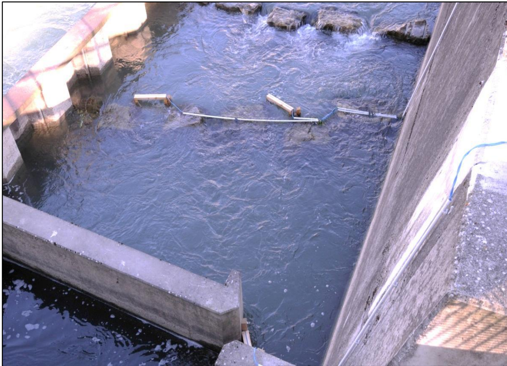
Abb. 128: Einstiegsbereich des Raugerinne-Beckenpasses Wyhlen (D) mit einem Wechsel der Bauweise von Beton- zu Natursteinriegeln
