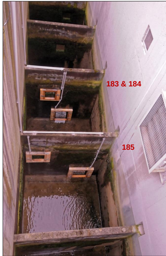
Abb. 55: Blick in den weitgehend gelenzten Beckenpass mit den Einzel- bzw. Doppelantennen Nr. 183 bis 185 vor en Schlupflöchern
