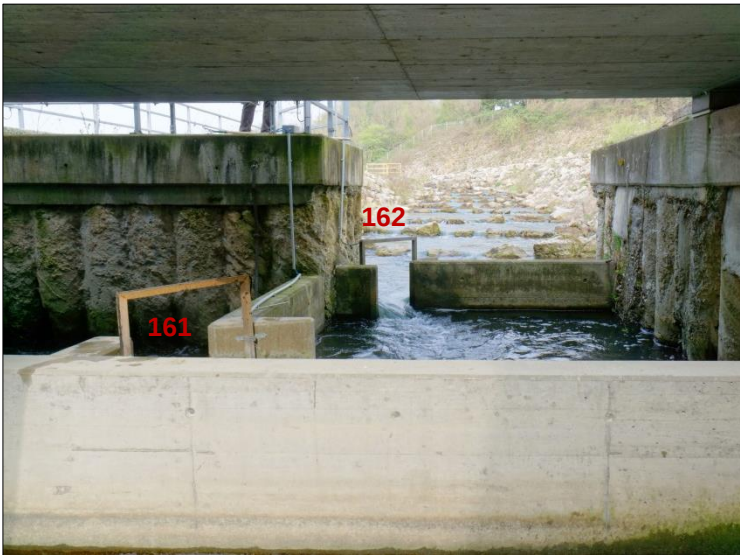
Abb. 44: Position der HDX-Antennen Nr. 161 und 162 vor dem Übergang in den Raugerinne-Beckenpass
