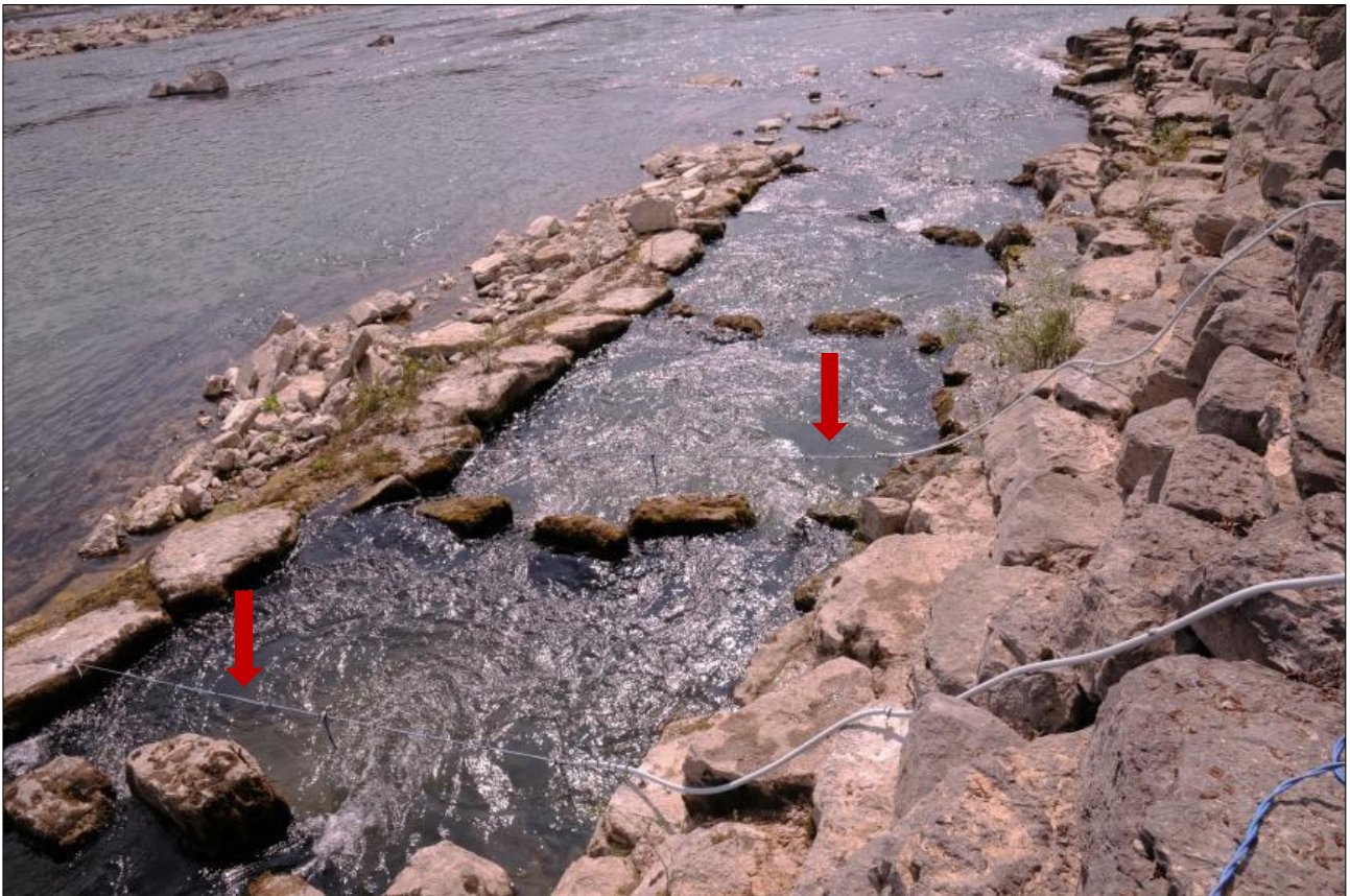
Abb. 5: Zwei Seilantennen im Raugerinne-Beckenpass in Rheinfelden (D)
