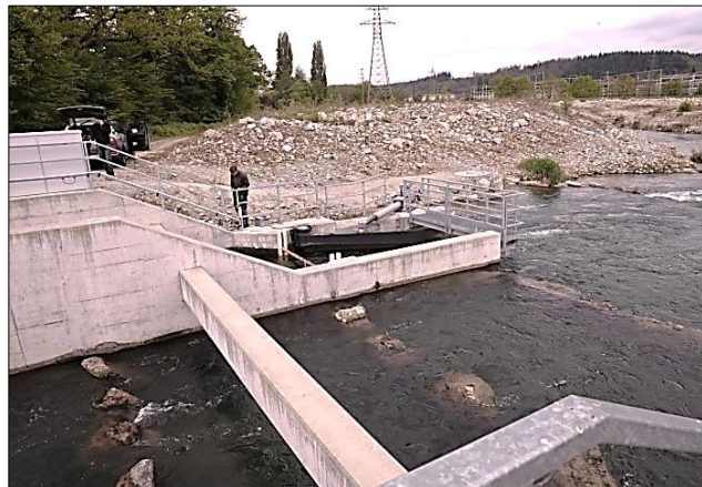
Abb. 41: Zweigeteiltes Einlaufbauwerk in das Umgehungsgerinne
