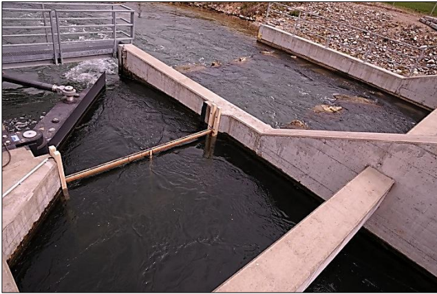
Abb. 51: Rahmenantennen Nr. 173 im Einlaufbauwerk vor dem Schwenktor
