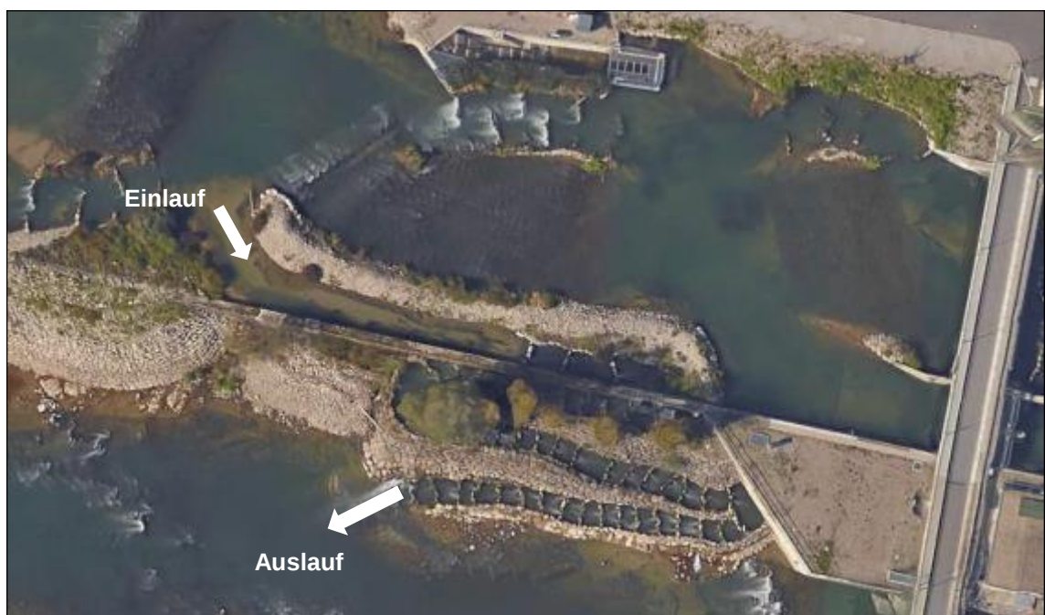
Abb. 32: Vom Fuss des Wehres zieht ein dreifach gewendelter Raugerinne-Beckenpass zum Umgehungsgewässer
