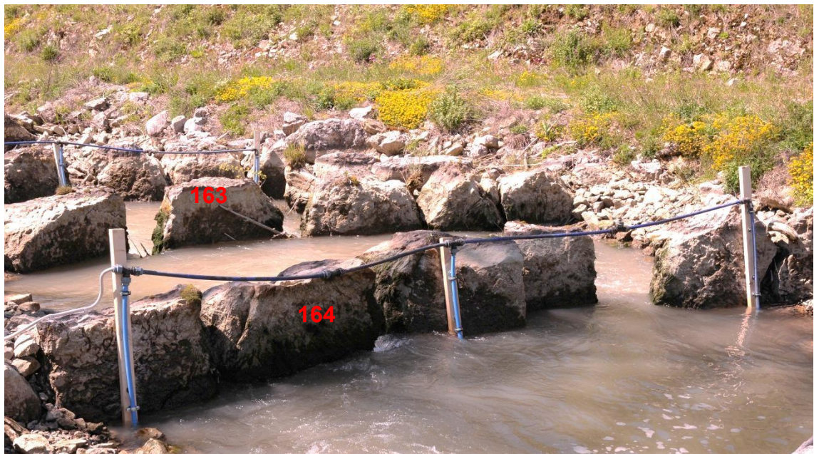
Abb. 48: Raugerinne-Beckenpass Ryburg-Schwörstadt mit den Antennen Nr. 163 und 164 an Steinriegel Nr. 2 und 4 stromab der Aufzweigung
