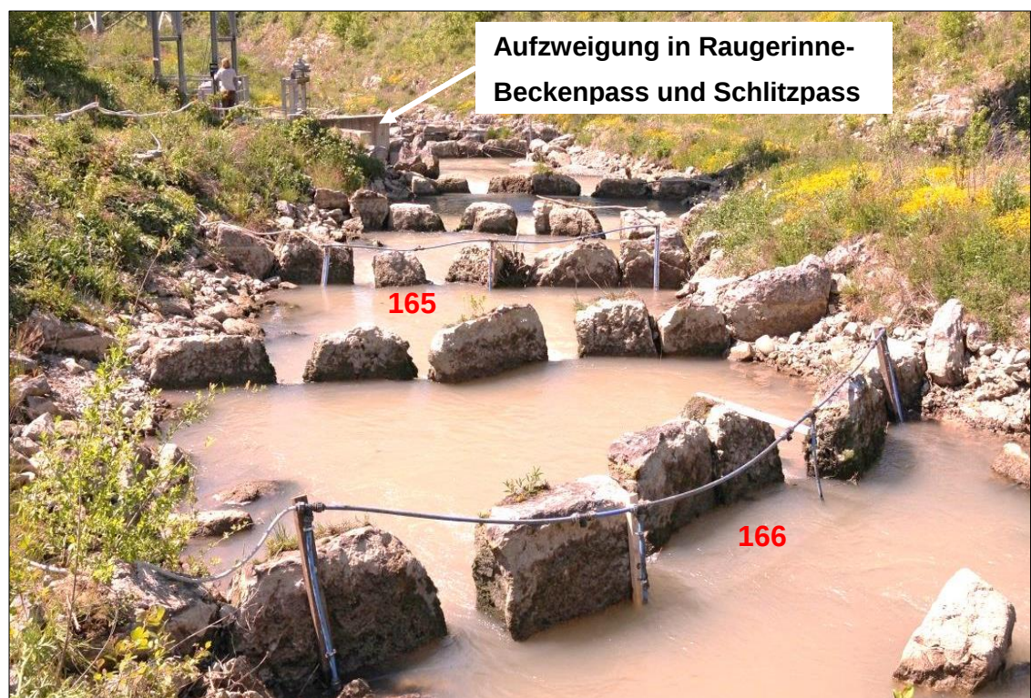
Abb. 49: Umgehungsgerinne Ryburg-Schwörstadt (D) mit den Antennen Nr. 165 und 166 an Steinriegel Nr. 3 und 5 stromauf der Aufzweigung
