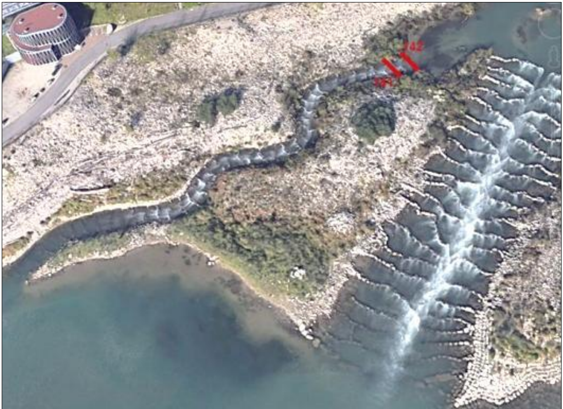
Abb. 24: Ufereinstieg des Umgebungsgewässer mit den Antennen Nr. 141 und 142, sowie die Mündungsrampe
