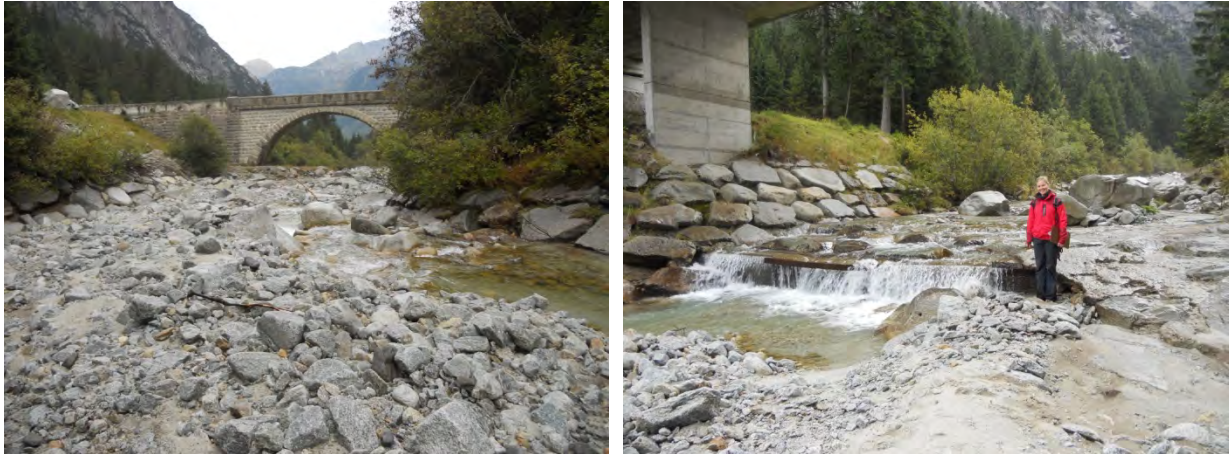
Standort 1, Unterhalb Handegg: Grobe Blöcke sind erkennbar. Die Absturzhöhe der Schwelle beträgt 0.75 m.
