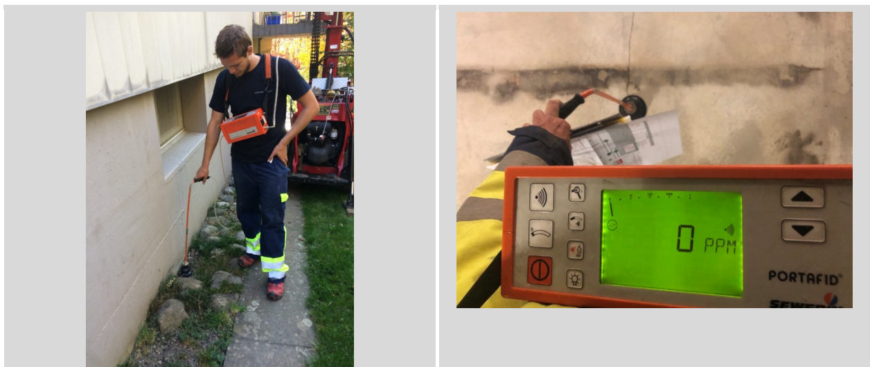
Abbildung 18: Bsp. Immissionsmessungen entlang Hausfassade oder an Rissen in der Bodenplatte
