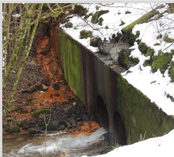
Abbildung 6b: Eisen-Mangan im Sickerwasser Altdeponie „Chüelochtobel“, Küssnacht am Rigi
