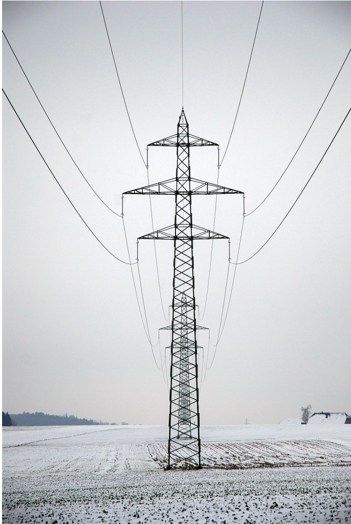
Abbildung 8: Bestimmen der Leitungsachse in Iffwil aus Masten in gerader Linie.
