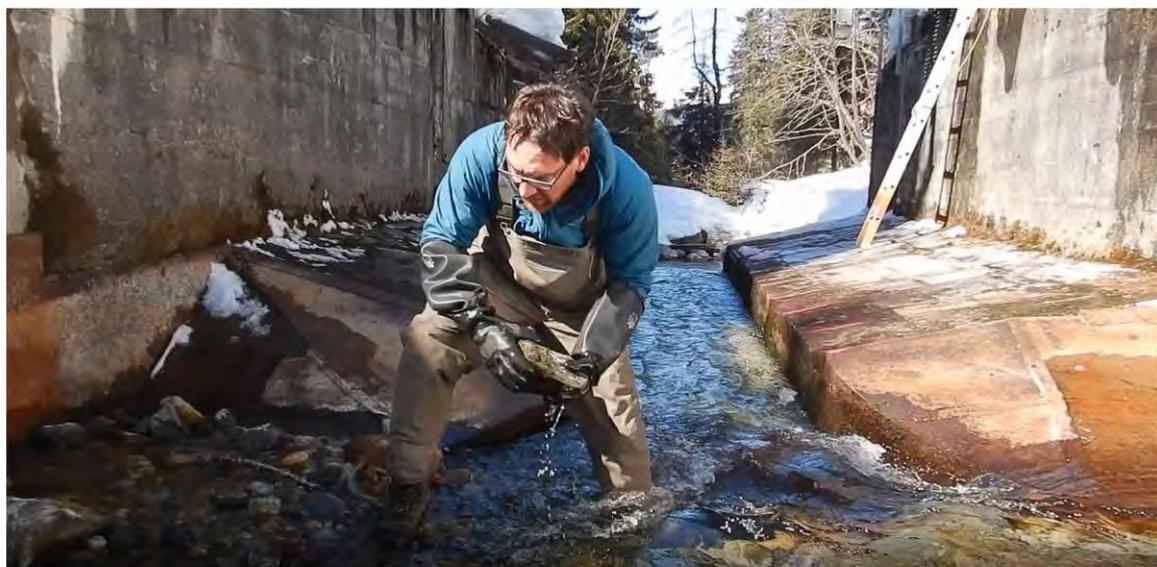
*Abbildung 171: Dischmabach, Entfernung der Steine aus dem Vorbecken vor der Messrinne am 14.03.2022 (Bild R. Kaderli).*
