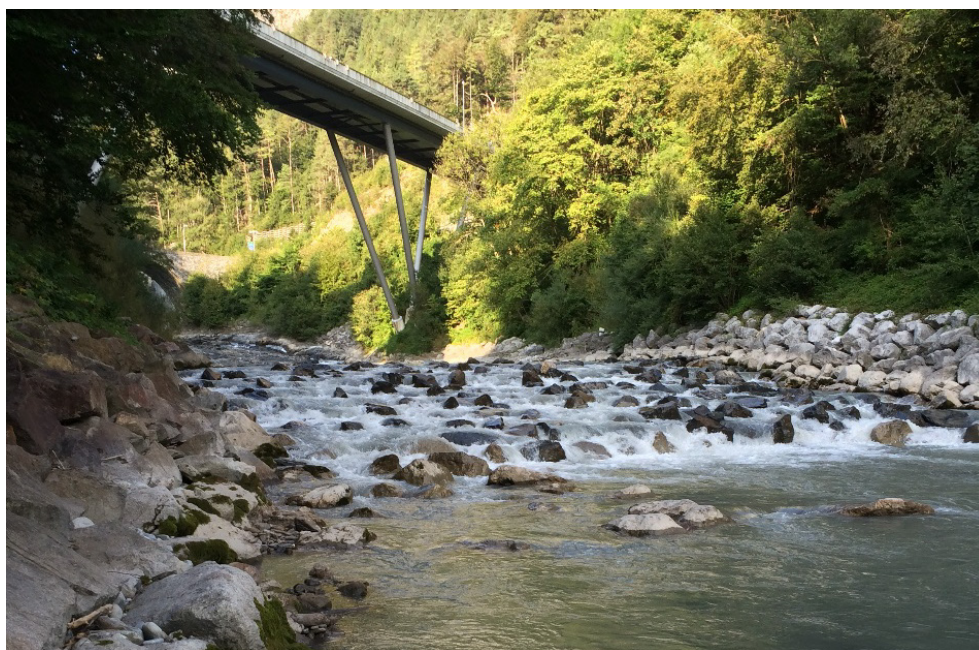
Figure 8 – Exemple de rampe en enrochements libres
