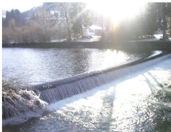
Figure 85 – Prise de vue d'un seuil
